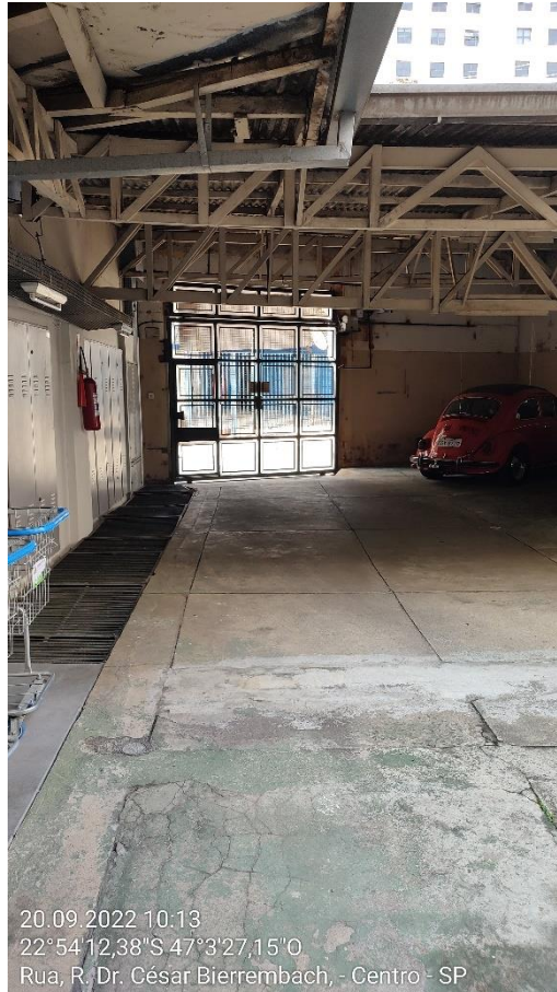
FOTO 17 – GARAGEM DO EDIFÍCIO
