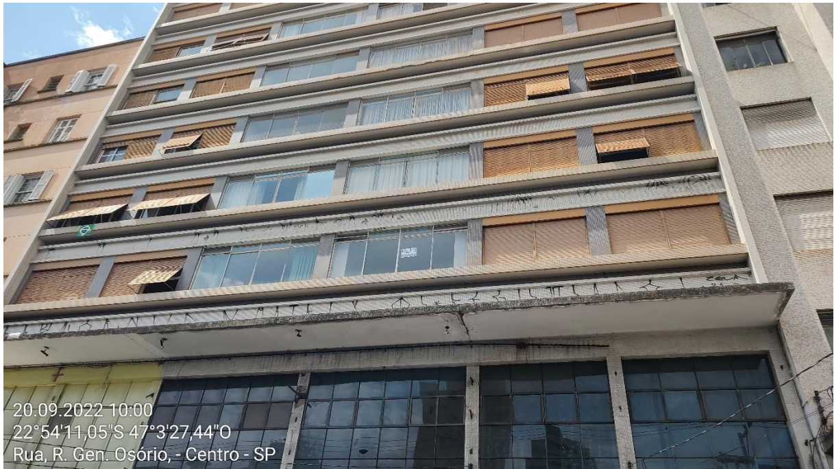
FOTO 01 – FACHADA DO EDIFÍCIO
