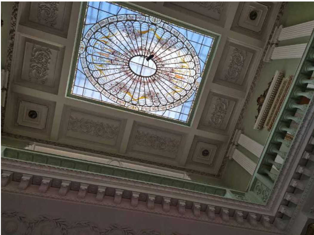
Fotografia 21 – Aspecto interno da edificação principal (Pavimento Térreo).
