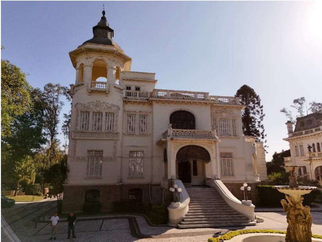
Fotografia 08 – Aspecto frontal da edificação principal.
