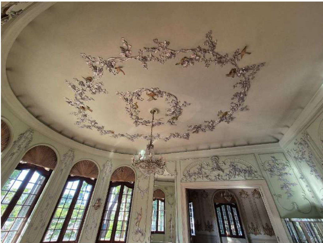
Fotografia 19 – Aspecto interno da edificação principal (Pavimento Térreo).
