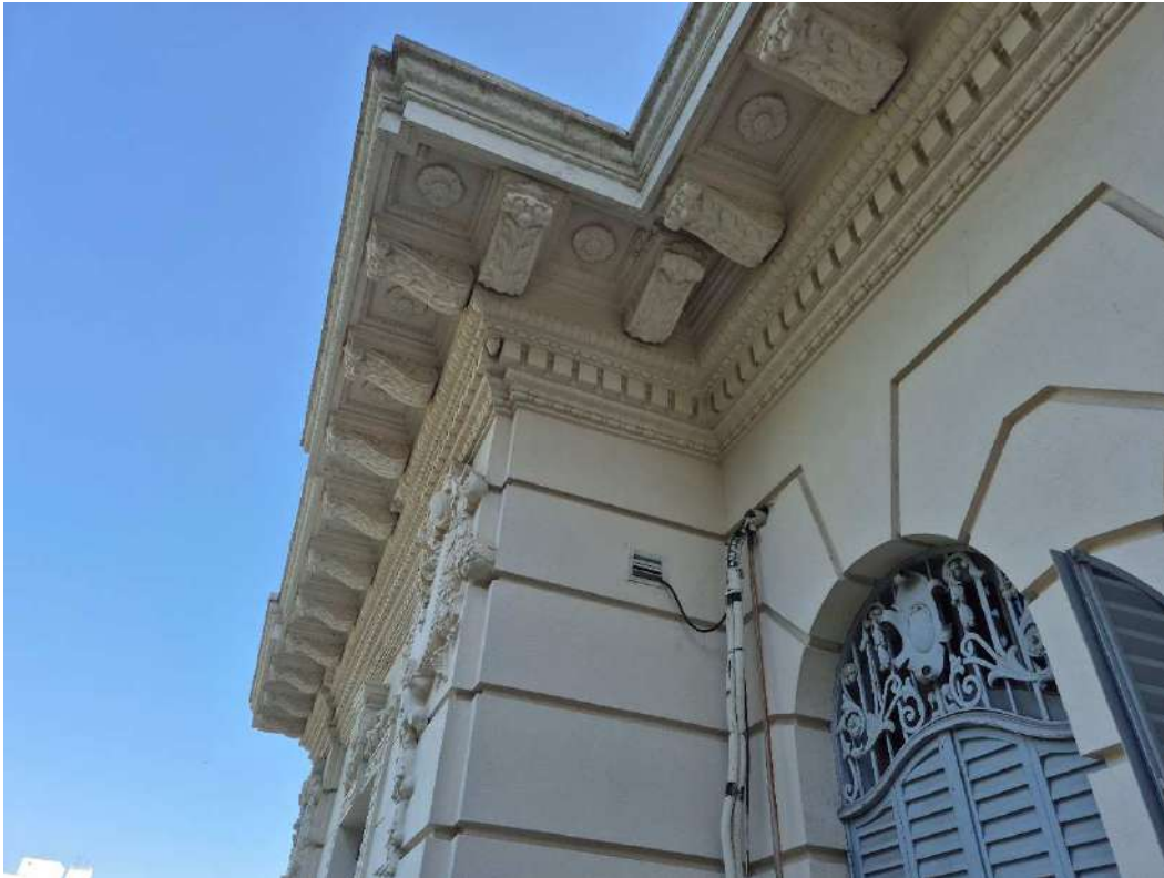
Fotografia 30 – Aspecto dos detalhes construtivos da fachada externa da edificação principal.
