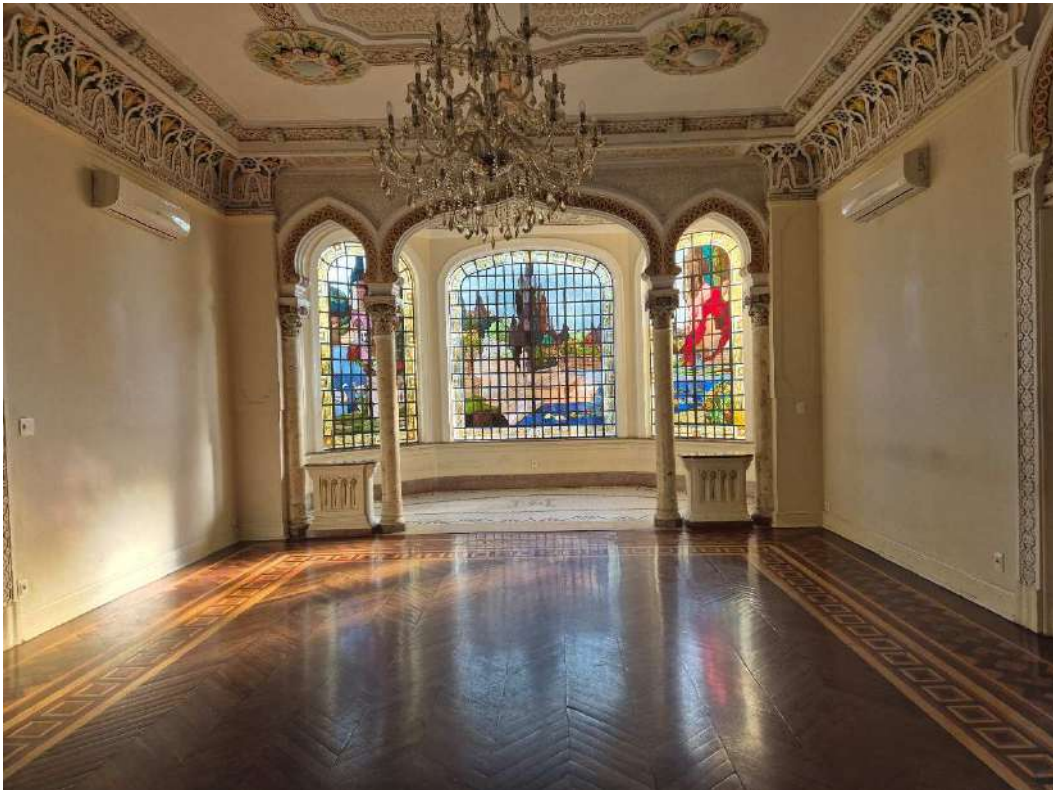
Fotografia 15 – Aspecto interno da edificação principal (Pavimento Térreo).
