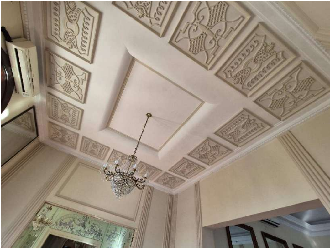
Fotografia 18 – Aspecto interno da edificação principal (Pavimento Térreo).
