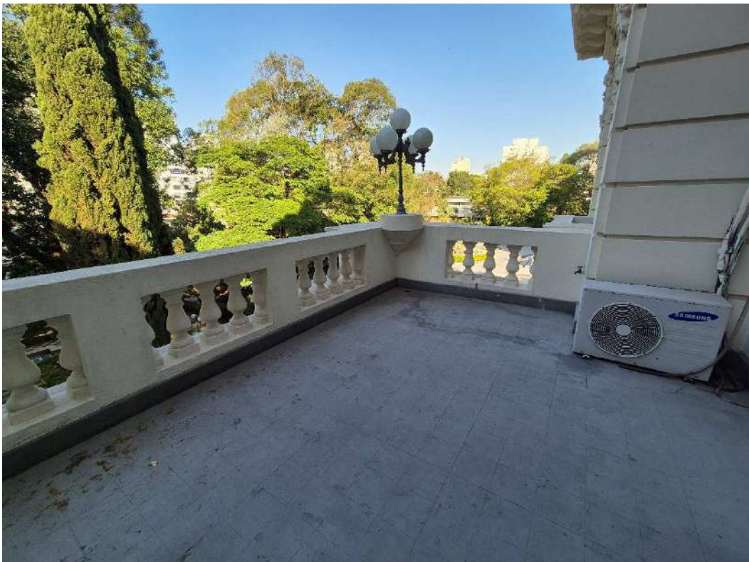
Fotografia 29 – Aspecto interno da edificação principal (Pavimento Superior).
