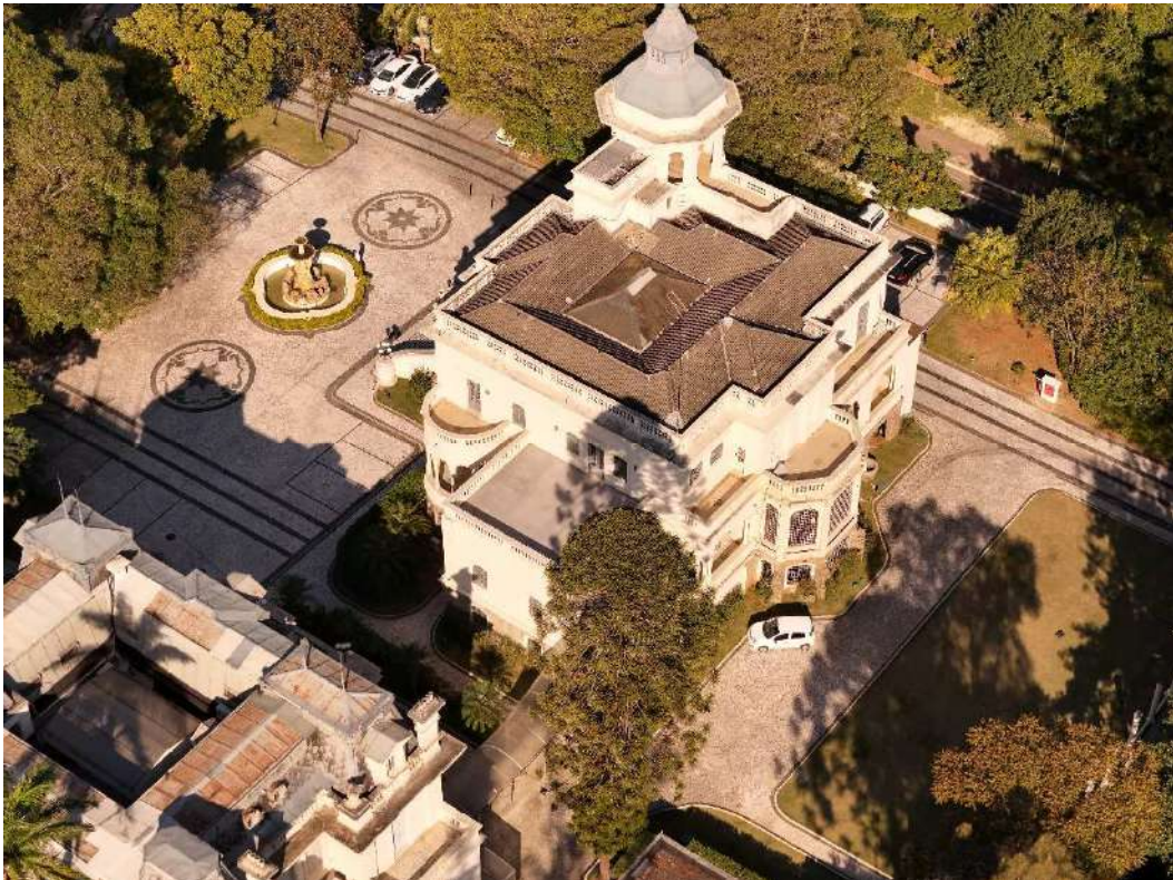
Fotografia 35 – Aspecto da área externa do imóvel avaliado.
