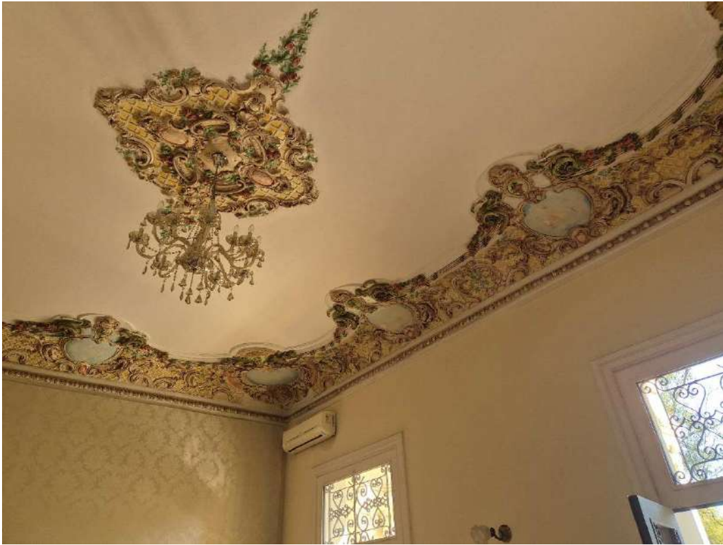
Fotografia 18 – Aspecto interno da edificação principal (Pavimento Térreo).
