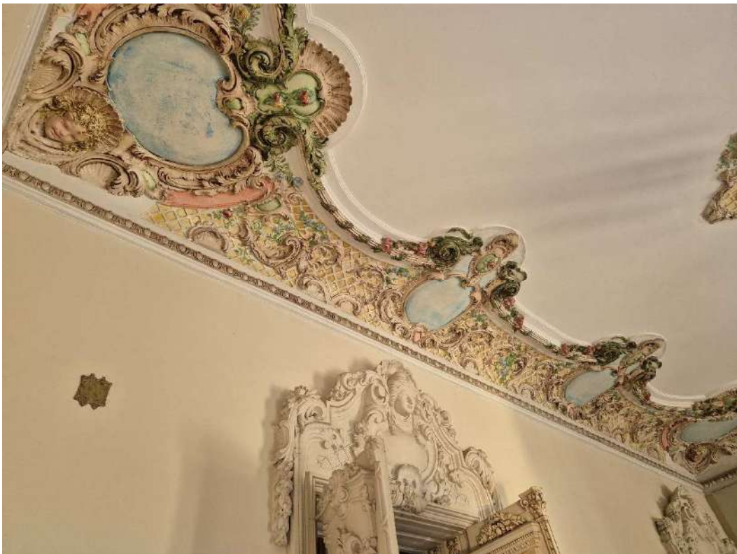
Fotografia 17 – Aspecto interno da edificação principal (Pavimento Térreo).
