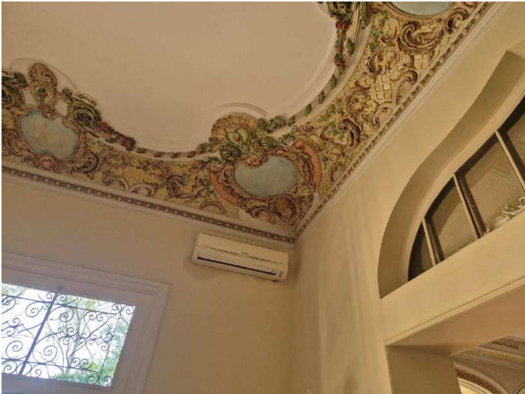
Fotografia 19 – Aspecto interno da edificação principal (Pavimento Térreo).
