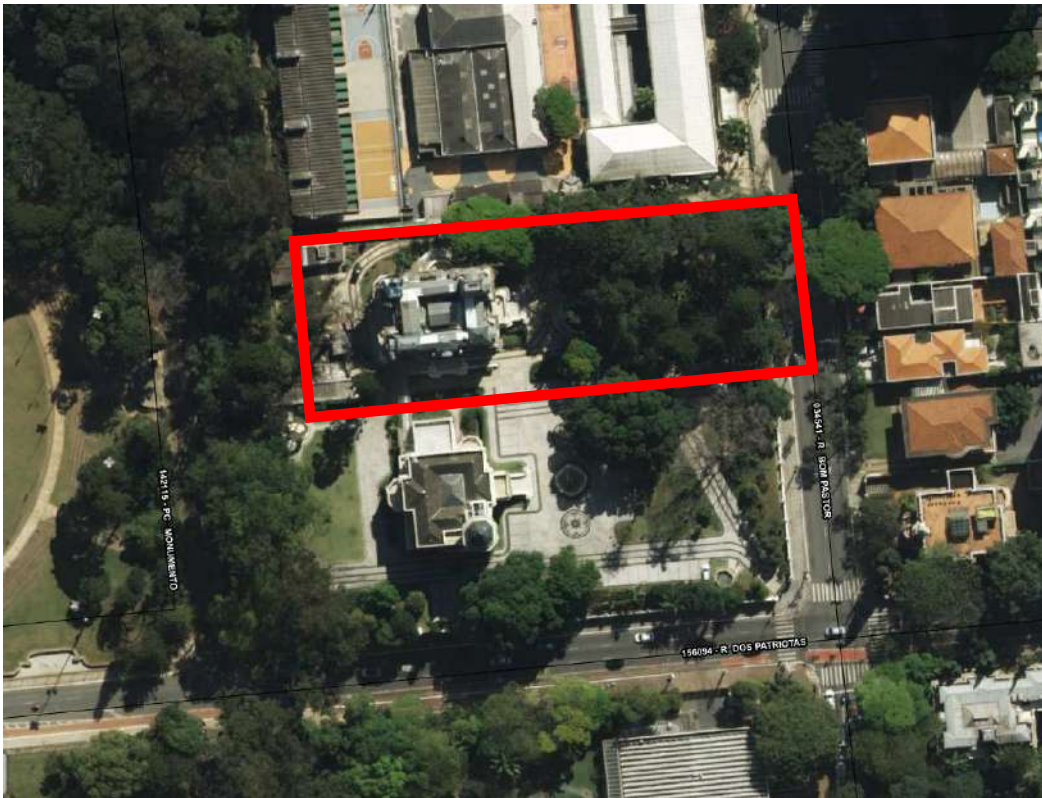
Fotografia 02 – Aspecto das divisas do imóvel avaliado (em vermelho) e sua localização na Rua Bom Pastor (a qual o imóvel avaliado faz frente).
