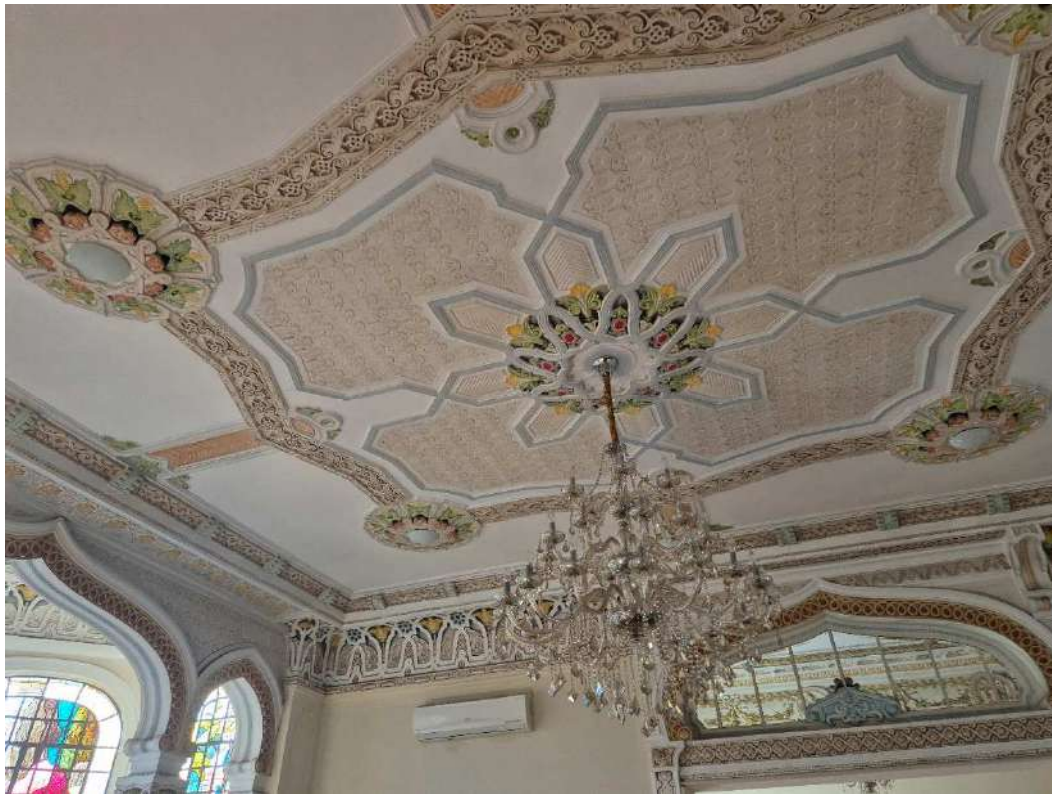
Fotografia 20 – Aspecto interno da edificação principal (Pavimento Térreo).
