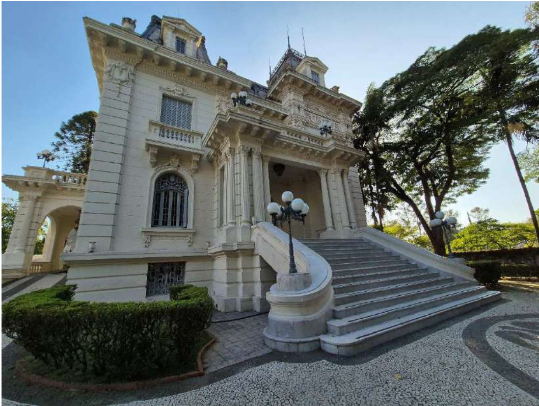
Fotografia 08 – Aspecto frontal da edificação principal.
