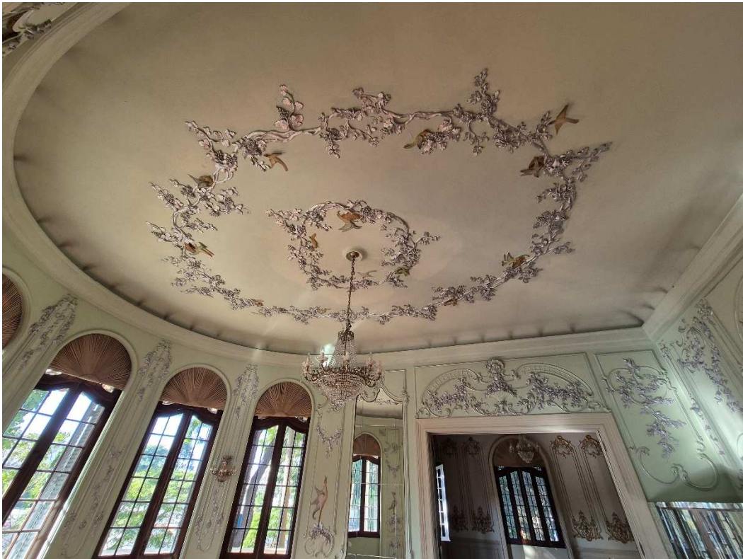
Fotografia 19 – Aspecto interno da edificação principal (Pavimento Térreo).
