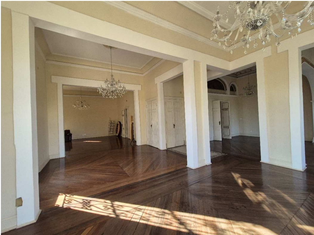
Fotografia 27 – Aspecto interno da edificação principal (Pavimento Superior).
