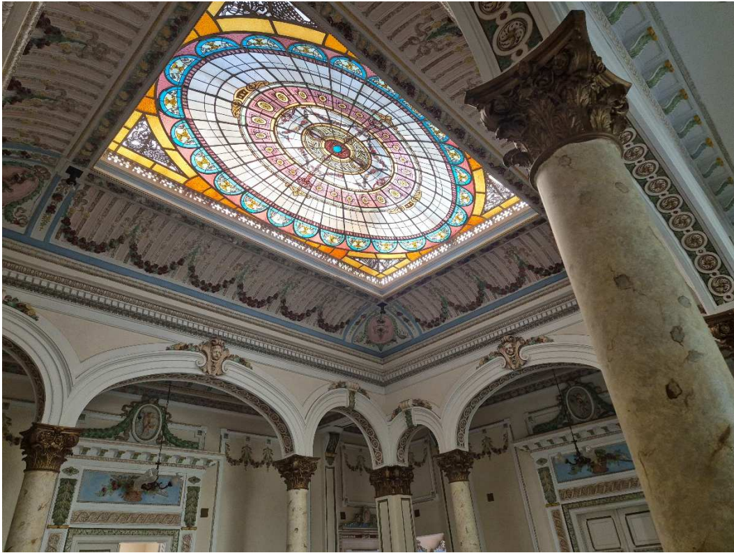
Fotografia 24 – Aspecto interno da edificação principal (Pavimento Superior).
