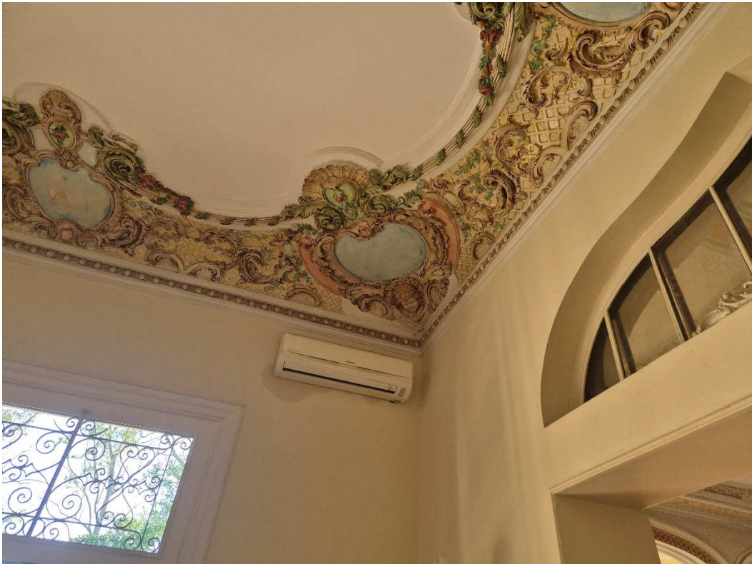
Fotografia 19 – Aspecto interno da edificação principal (Pavimento Térreo).
