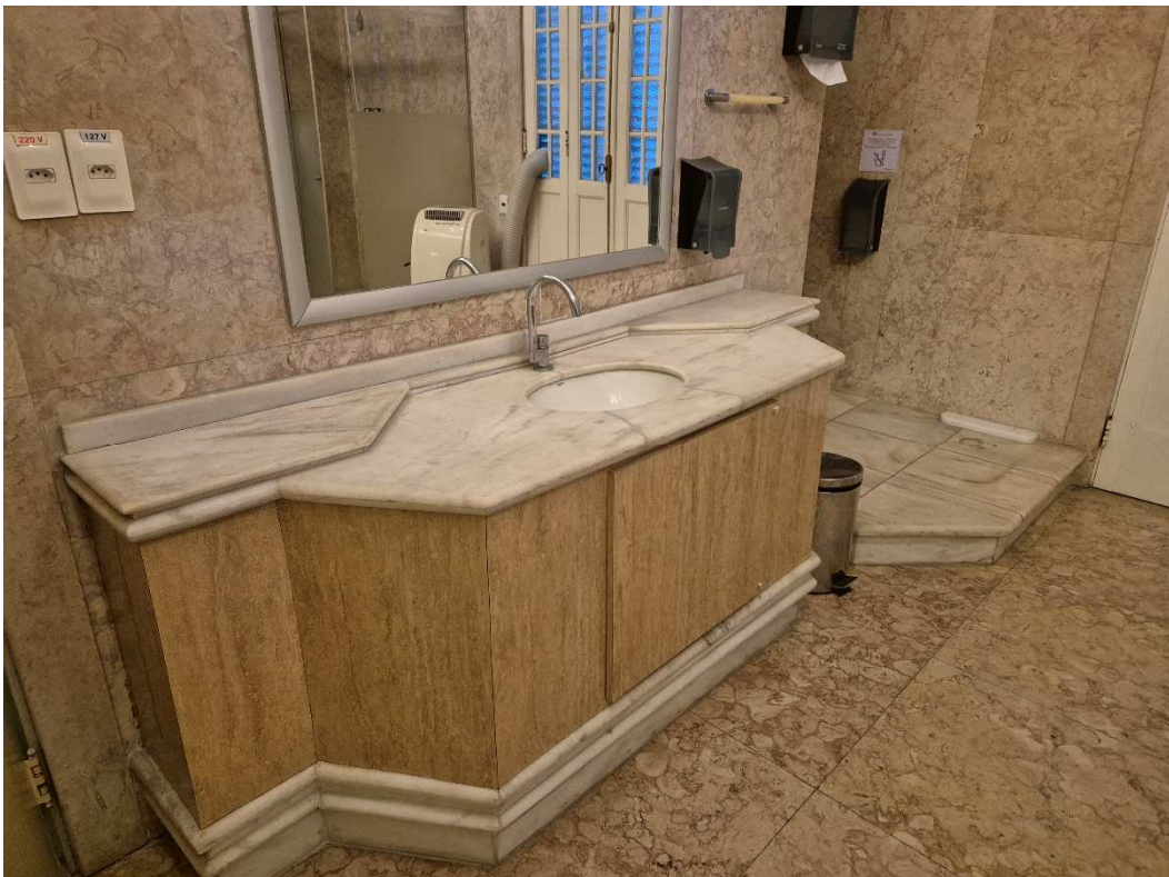
Fotografia 27 – Aspecto interno da edificação principal (Pavimento Superior).
