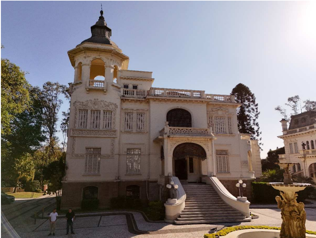
Fotografia 08 – Aspecto frontal da edificação principal.
