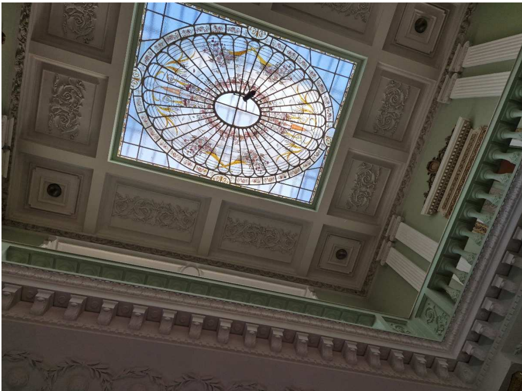
Fotografia 21 – Aspecto interno da edificação principal (Pavimento Térreo).
