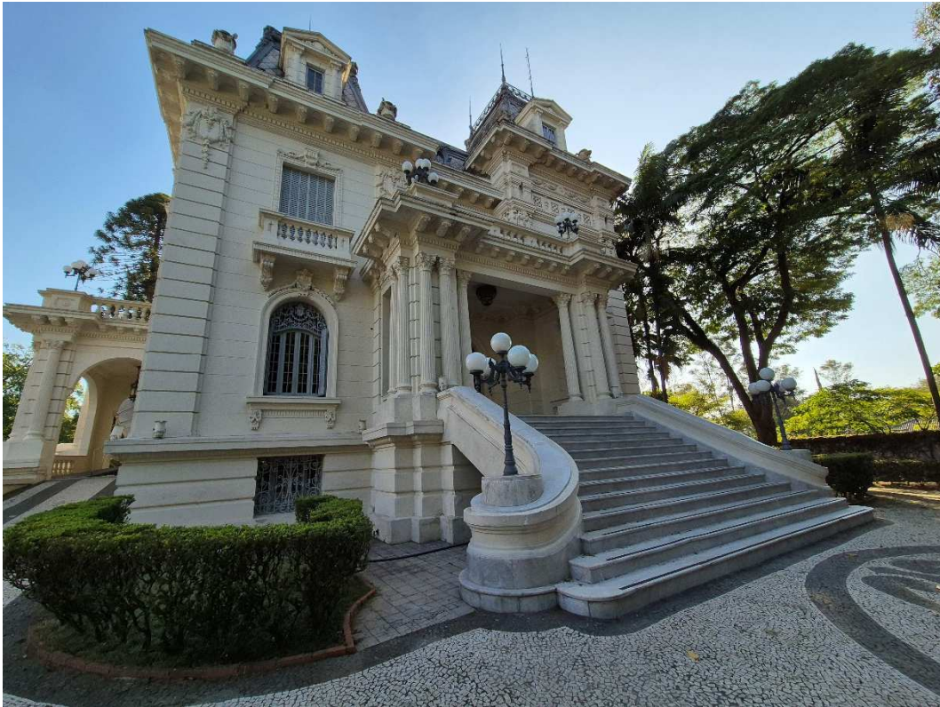
Fotografia 08 – Aspecto frontal da edificação principal.
