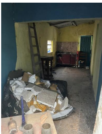
Foto 9 - Vista da construção existente.
