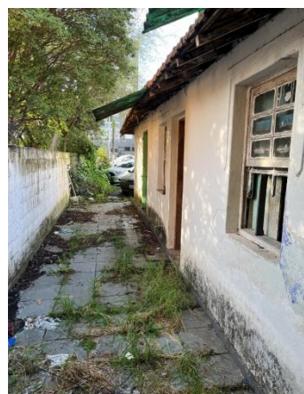
Foto 8 - Vista da construção existente.
