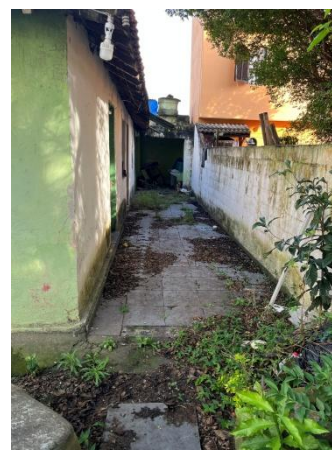
Foto 4 - Vista da construção existente.
