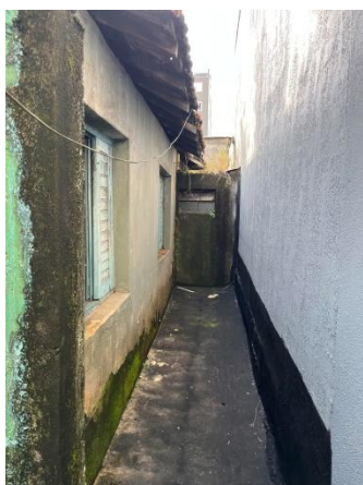
Foto 7 - Vista da construção existente.
