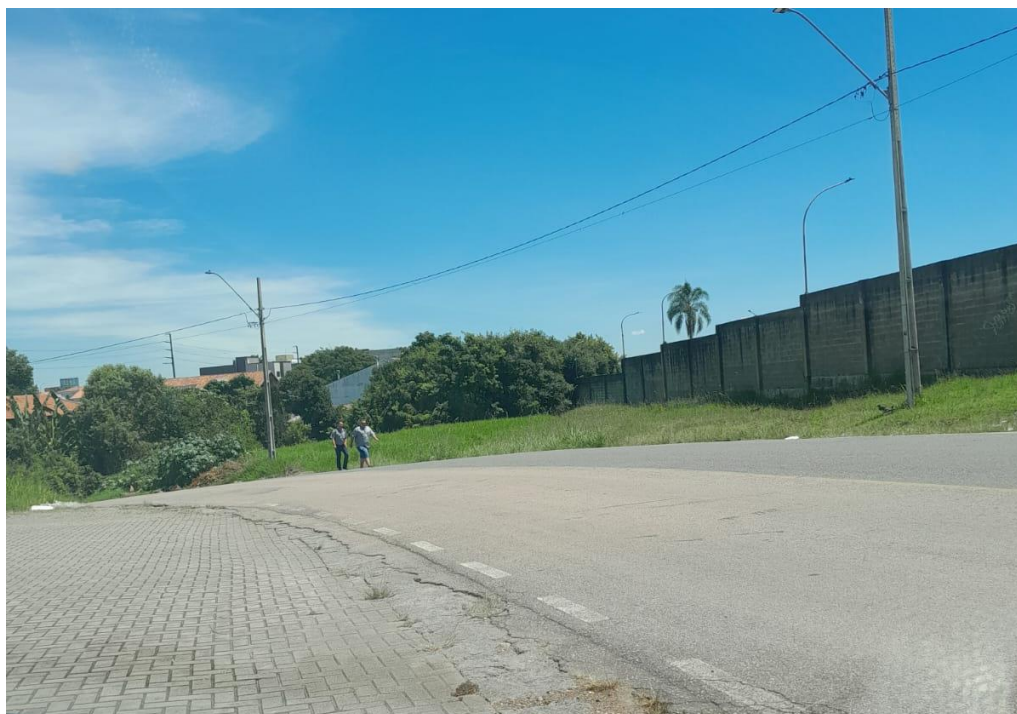
Imagem 16 – Vista frontal do imóvel
