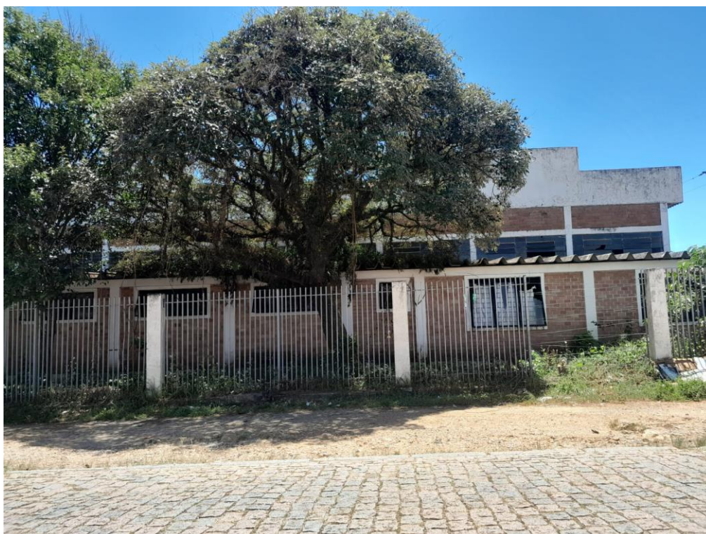
Imagem 9 – Vista externa do prédio aparentemente administrativo pela rua Rio Grande do Norte
