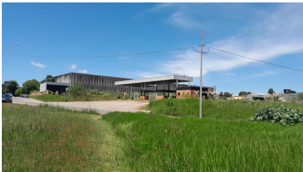
Imagem 14 – Vista geral externa pela rua José Maurílio da Cruz
