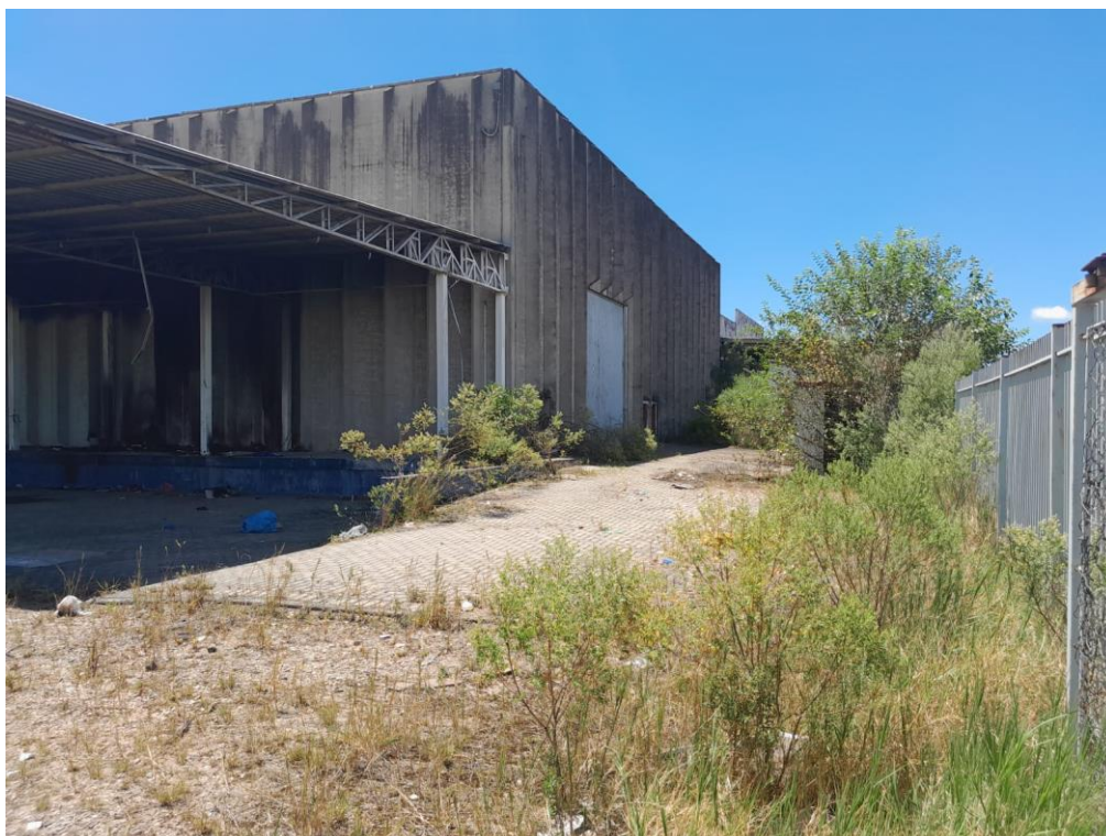
Imagem 6 – Vista interna dos fundos do imóvel
