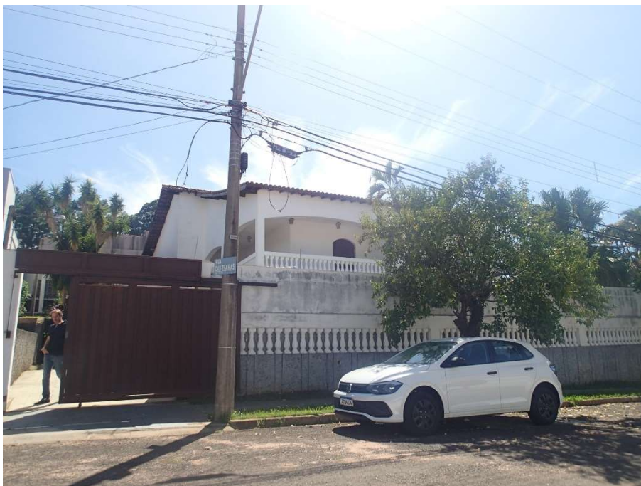
Fachada principal do imóvel com frente para a Rua das Traíras.
