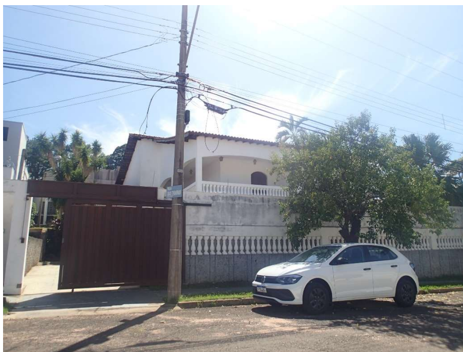
Fachada do avaliando
