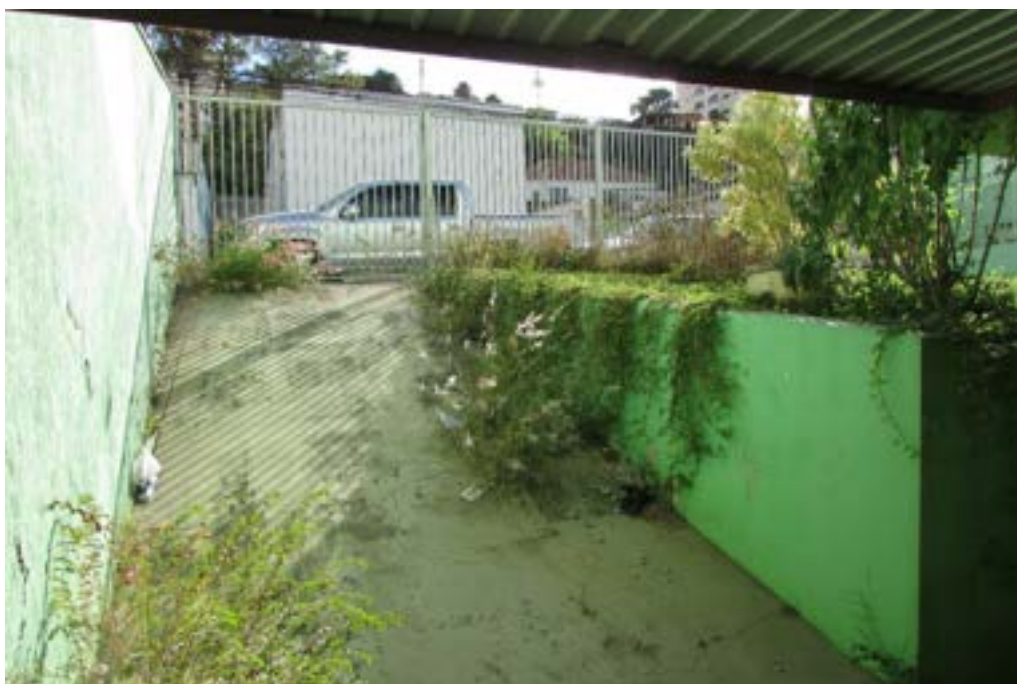
26 – Vista interna da rampa de acesso ao pavimento térreo
