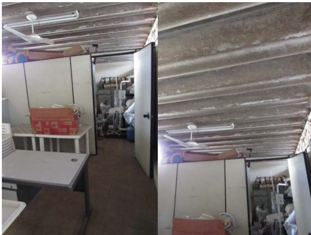
30 – Edícula – Vista interna e telhado tipo calhetão
