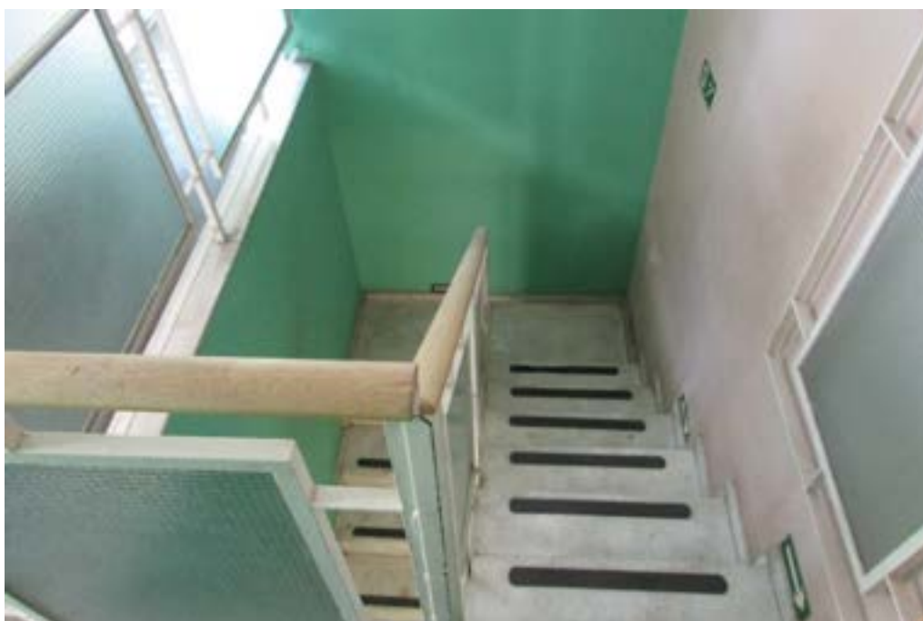
17- Escada de acesso ao pavimento térreo
