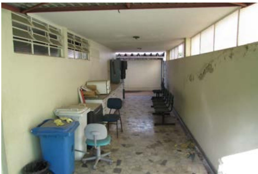
27- Corredor de acesso a Edícula aos fundos – Pavimento térreo
