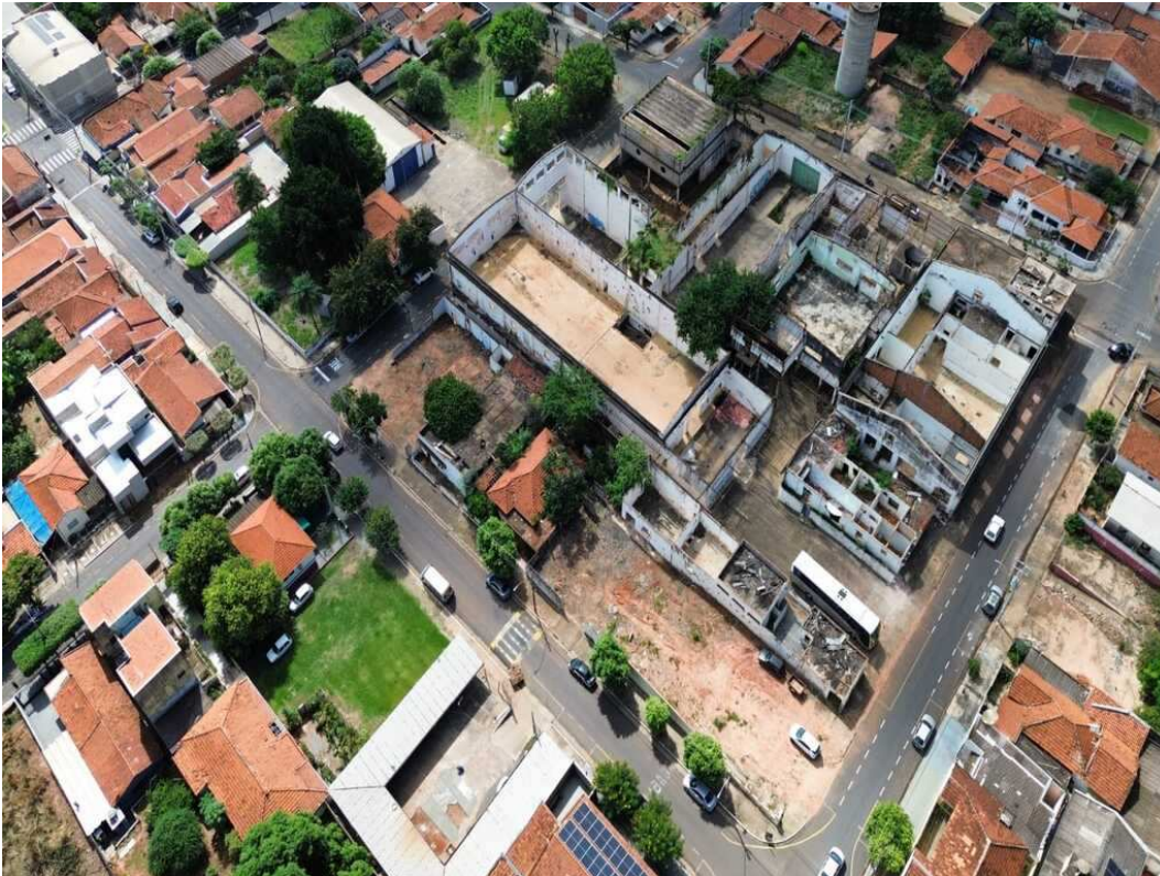
Fotografia 07 - Aspecto do imóvel avaliado e das construções existentes em estado de ruína.
