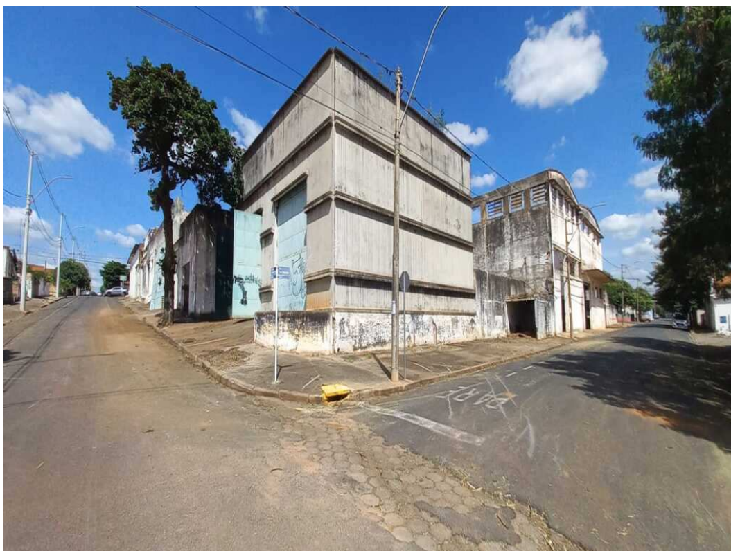
Fotografia 16 – Aspecto do imóvel avaliado e das construções existentes em estado de ruína.
