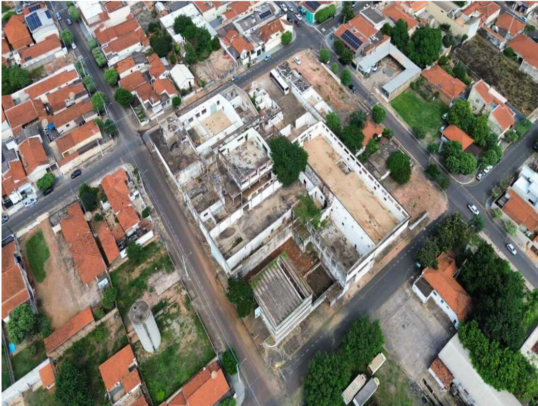
Fotografia 05 – Aspecto geral do imóvel.
