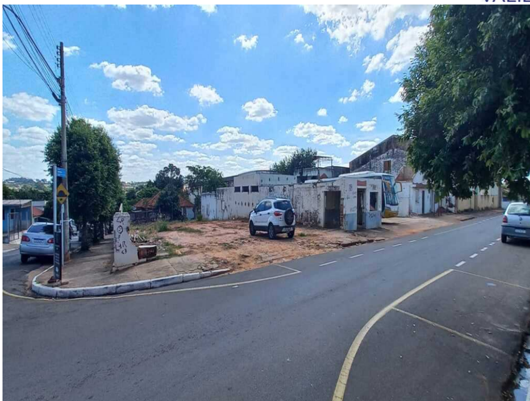
Fotografia 17 – Aspecto do imóvel avaliado e das construções existentes em estado de ruína.
