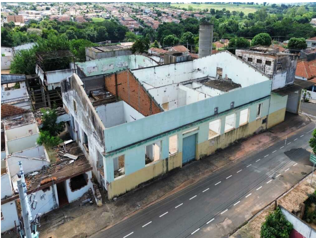
Fotografia 10 – Aspecto do imóvel avaliado e das construções existentes em estado de ruína.
