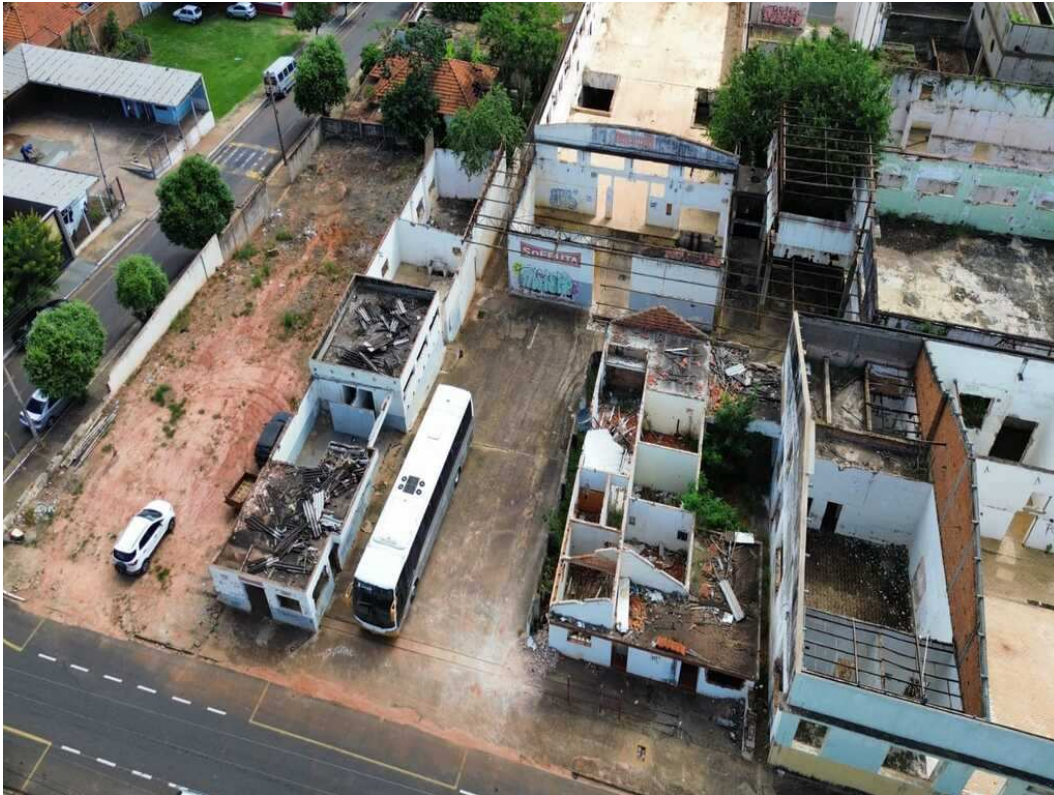
Fotografia 09 – Aspecto do imóvel avaliado e das construções existentes em estado de ruína.
