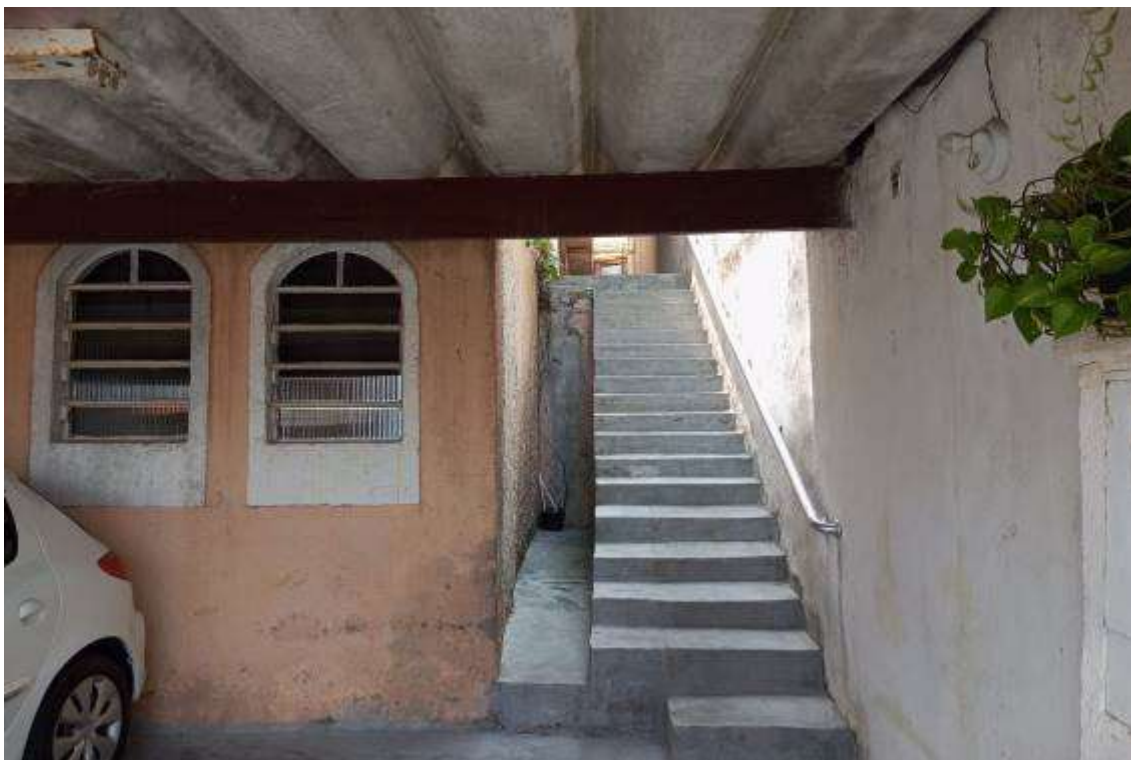
FOTO nº 06 Vista da escada de acesso ao pavimento superior.
