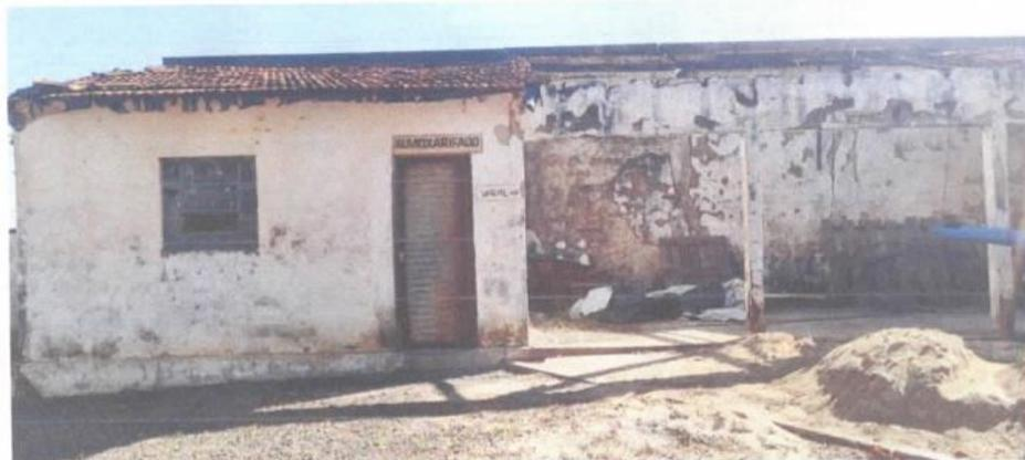
Construído em alvenaria, sem reboco, com piso em tijolos acentado com argamassa, sem forro, coberto com telhas francesas, medindo 8,30 m x 24,70 m com área total de 205,01 m<sup>2</sup>. Em mal estado de conservação.
