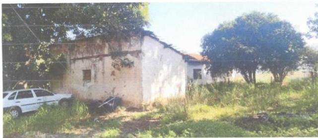
Casa de alvenaria, padrão popular, sem forro, coberta telha francesa sobre madeiramento, piso em vermelhão, com dois cômodos e um banheiro. Instalações a serem reparadas. Área 28,00 m<sup>2</sup>.
