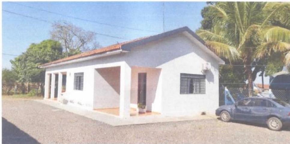
Residência de alvenaria de tijolos comuns, forrada com lage pré-moldada com telha francesa sobre madeiramento, com pisos cerâmicos, dividida internamente em: 2 dormitórios, 1 banheiro, 1 cozinha, 2 salas, área de serviço, varandas. Pintura, instalações elétricas e hidráulicas em bom estado. Boa conservação. Área total 124,82 m<sup>2</sup>.
