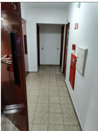
Foto 43 – Hal dos elevadores.
