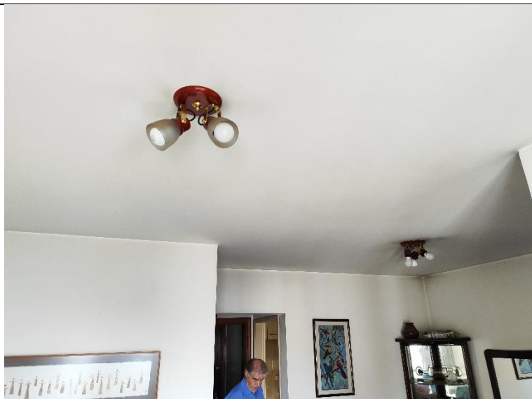
Foto 19 – Aspectos do teto e paredes da sala,
