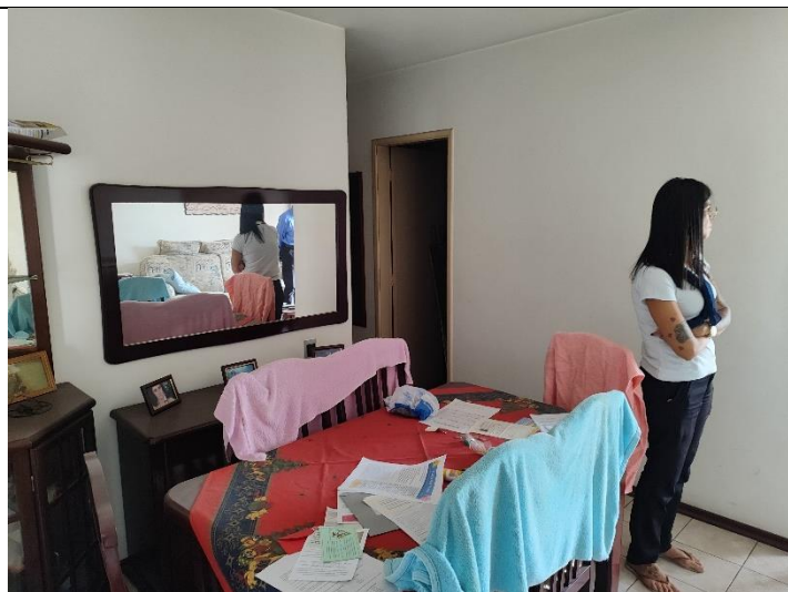
Foto 11 – Sala em L, piso cerâmico padrão, parede em massa corrida pintura látex PVA.
