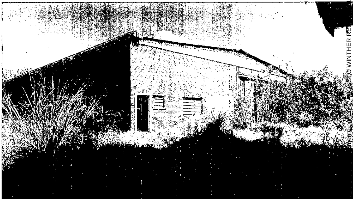
Fotografia 04 – Aspecto geral do imóvel avaliado.
