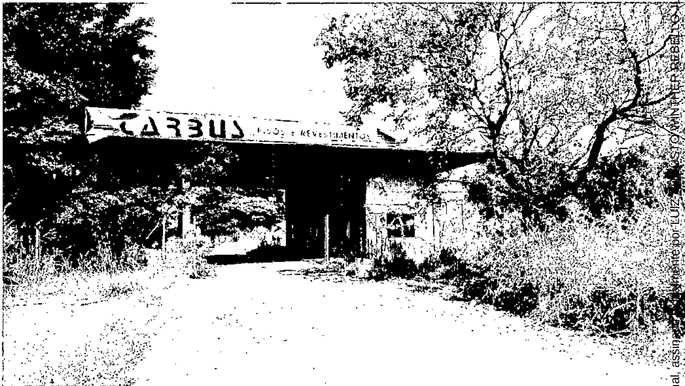
Fotografia 02 – Aspecto geral do imóvel avaliado.
