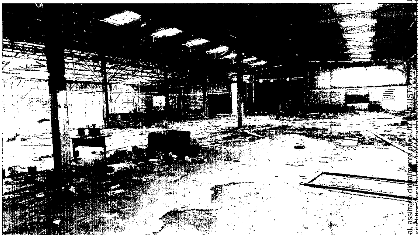
Fotografia 06 – Aspecto geral do imóvel avaliado.
