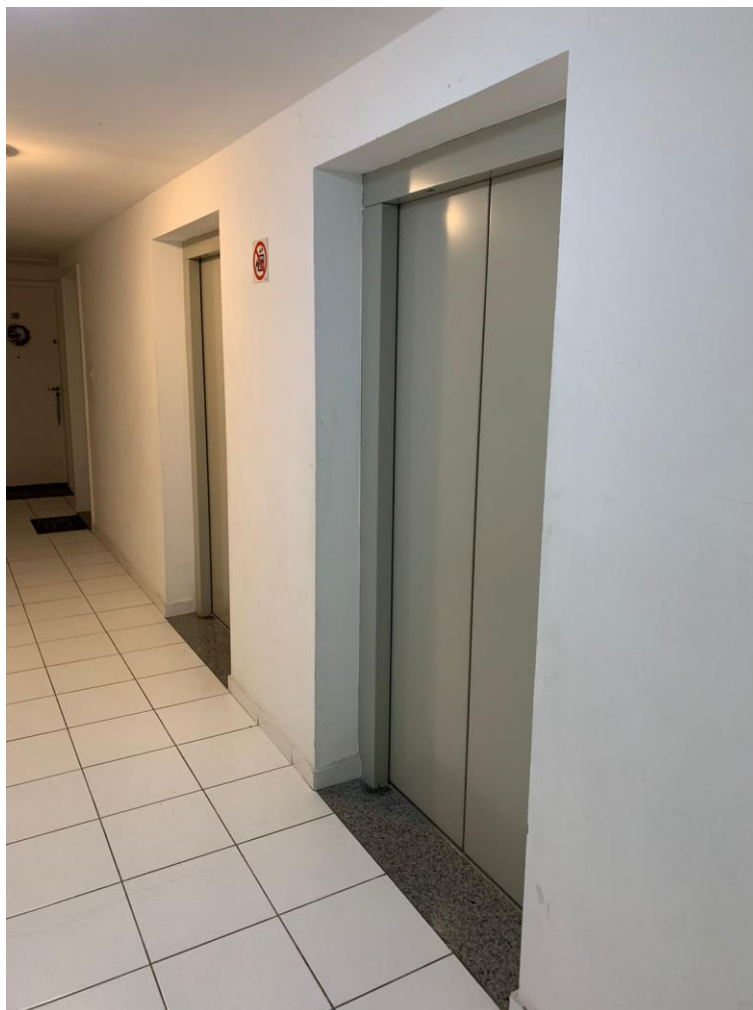
Foto nº. 22 – Vista dos elevadores localizados no 2º pavimento tipo.
