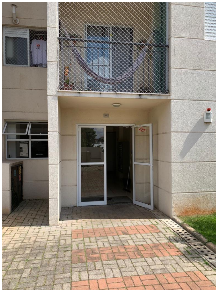
Foto nº. 19 – Vista da entrada do hall social.
