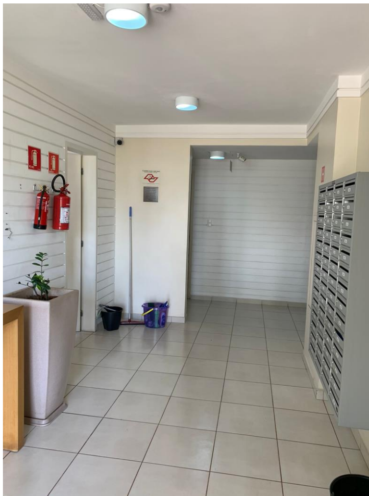
Foto nº. 20 – Vista do hall social.
