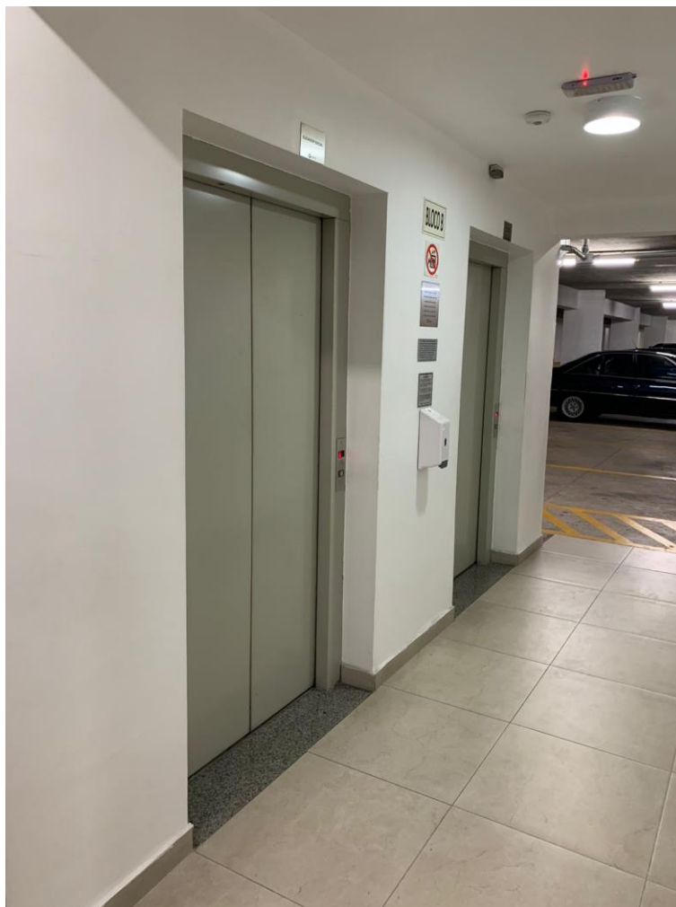
Foto nº. 17 – Vista dos elevadores localizados no subsolo.
