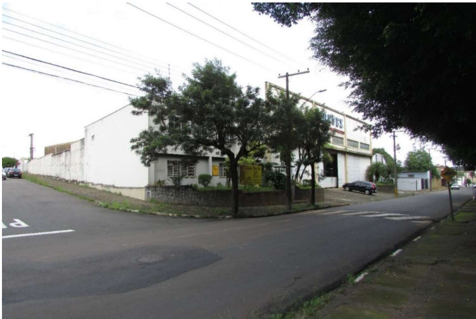
1- Vista externa do imóvel – Rua das Tulipas x Rua das Primaveras
