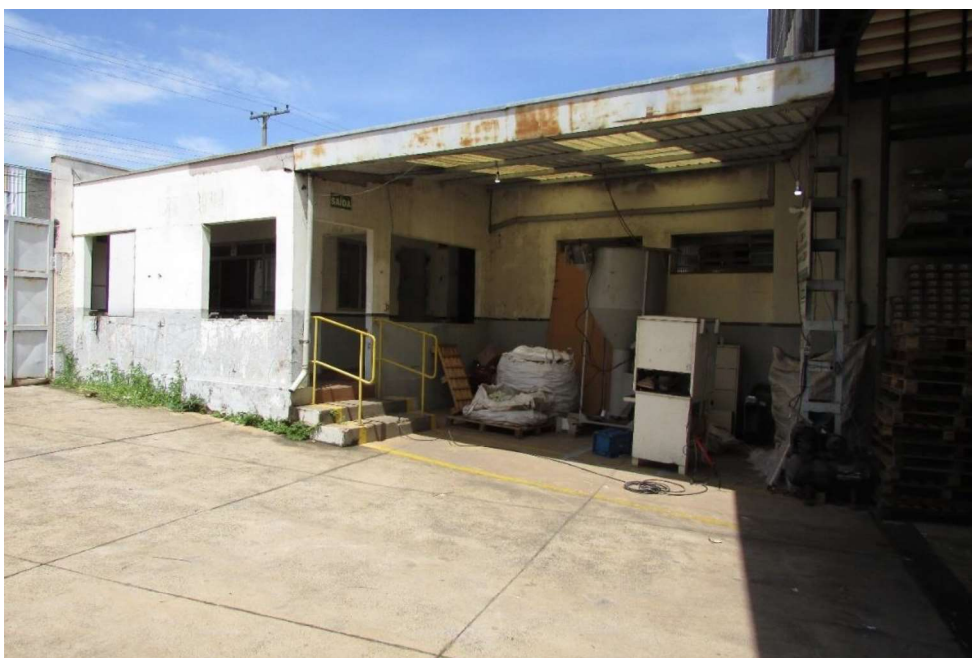
19- Guarita – vista externa do pátio
