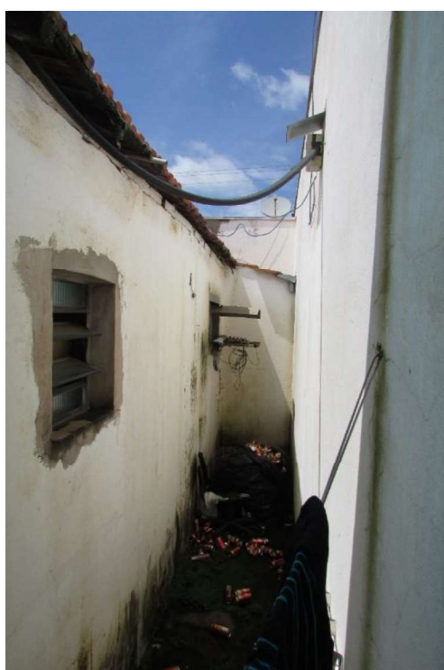
10- Corredor que dá acesso aos Galpões
