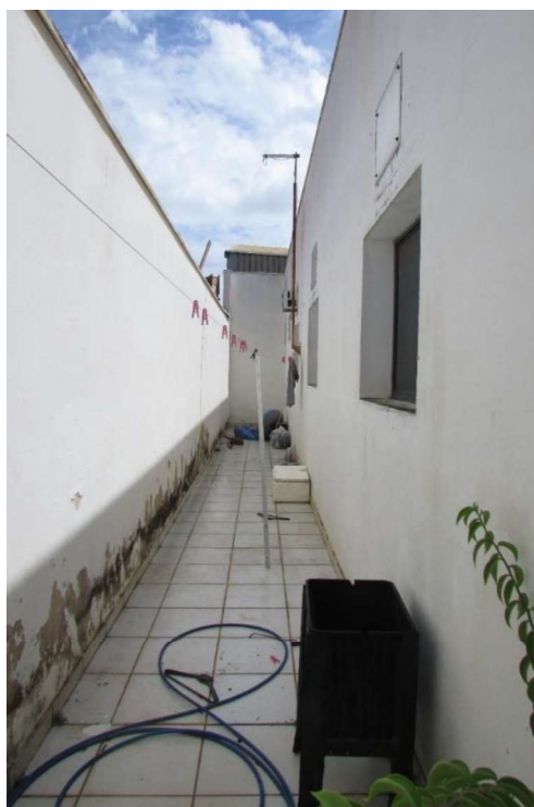
6- Corredor do imóvel residencial
