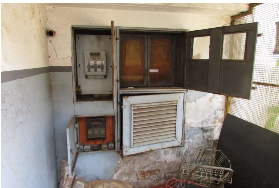
20- Quadros de energia elétrica desmontados
