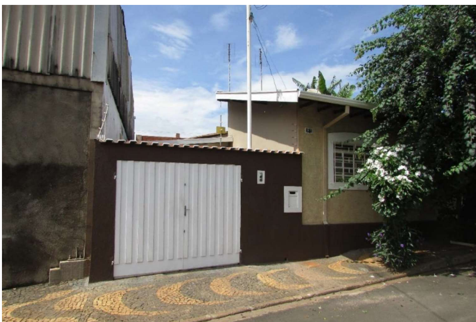
4- Rua das Camélias – Imóvel vizinho aos fundos
