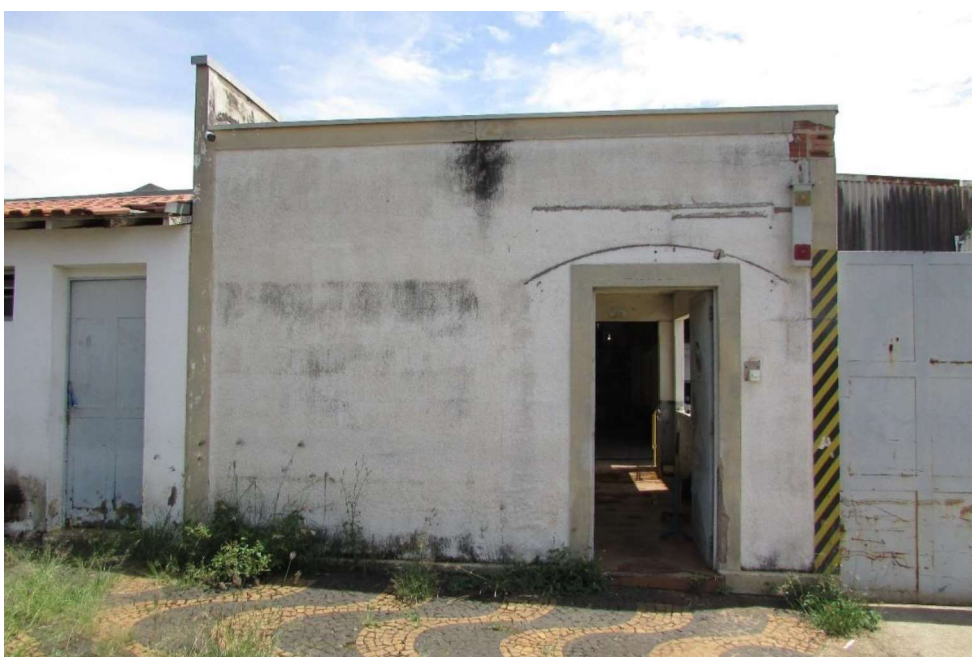
16- Edificação anexa - Guarita
