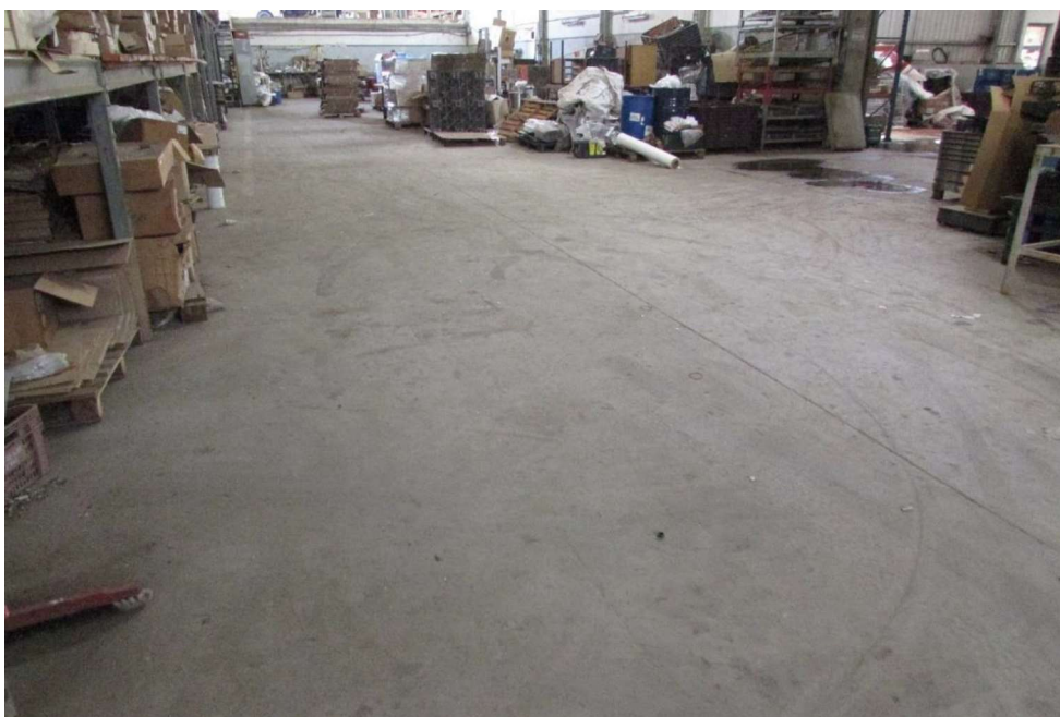
23- Piso do galpão
