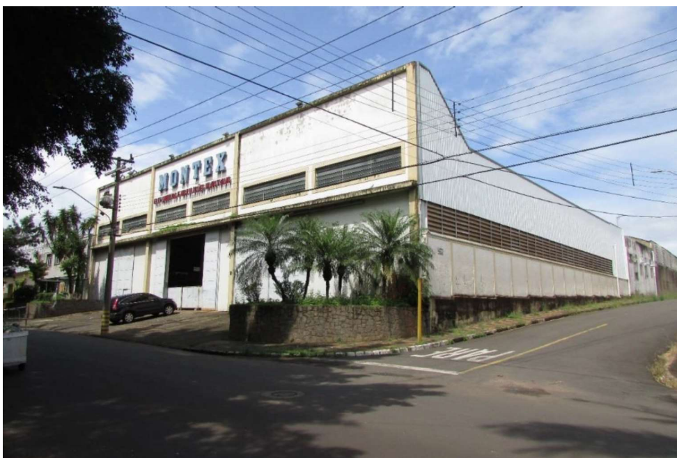
3- Vista externa do imóvel – Rua das Tulipas x Rua das Camélias
