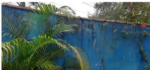
MURO EM CURVA – VISTA INTERNA
