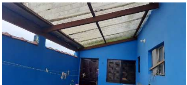
TELHADO DA ÁREA DE SERVIÇOS
