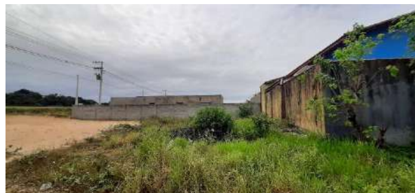
VISTA DOS FUNDOS PELA RUA R.G.SUL
