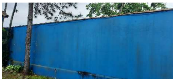
MURO DIVISA COM LOTE 15 - VISTA INTERNA
