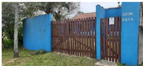
PORTÃO DE ENTRADA – VISTA EXTERNA
