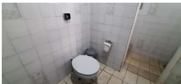
PISO E REVESTIMENTO – WC SOCIAL
