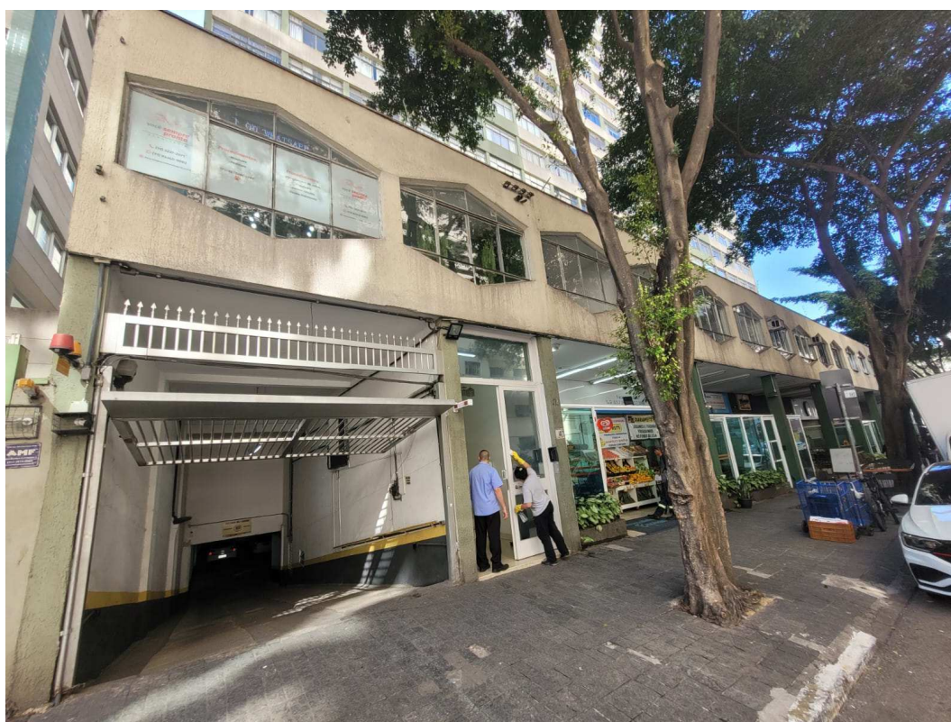
Fotografia 03 – Aspecto das sobrelojas do Condomínio Edifício Miguel Grassi e o acesso ao n° 474 da Rua Dona Antônia de Queiroz e subsolo de garagem.
