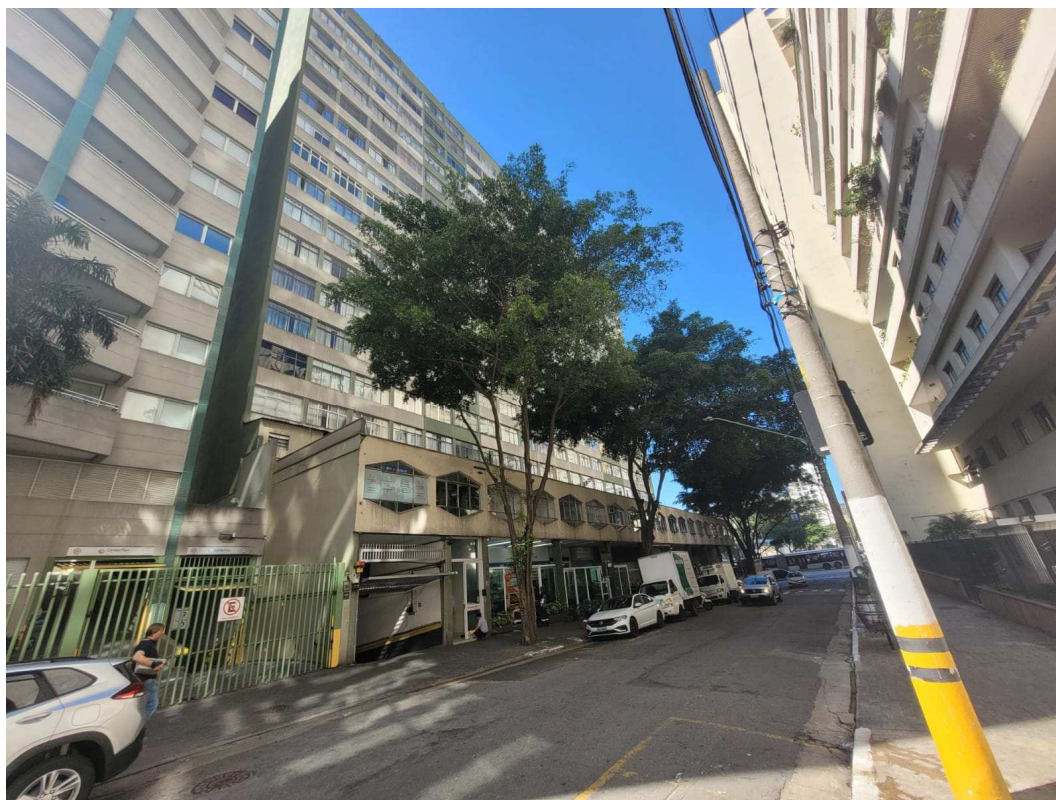
Fotografia 02 – Vista geral do Condomínio Edifício Miguel Grassi junto ao alinhamento da Rua Dona Antônia de Queiroz.
