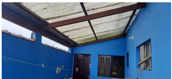
TELHADO DA ÁREA DE SERVIÇOS
