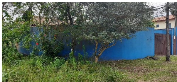
VISTA EXTERNA – ESQUINA – EM CURVA
