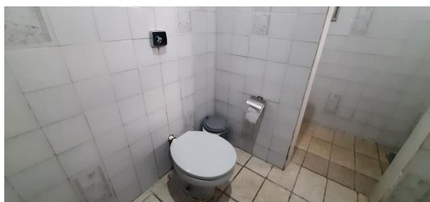
PISO E REVESTIMENTO – WC SOCIAL
