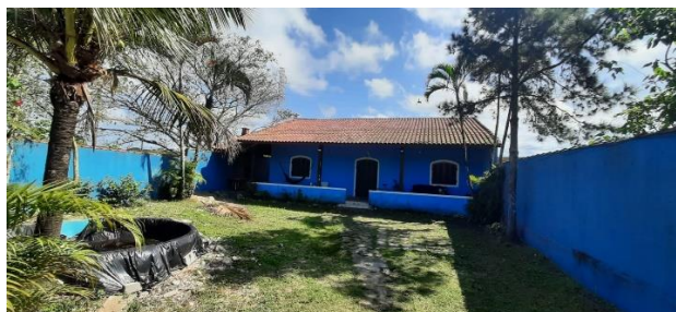
FACHADA E QUINTAL DA FRENTE
