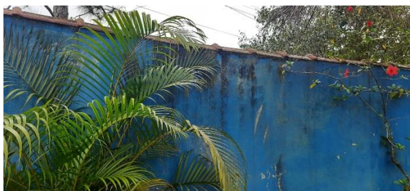
MURO EM CURVA – VISTA INTERNA
