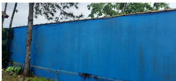
MURO DIVISA COM LOTE 15 - VISTA INTERNA
