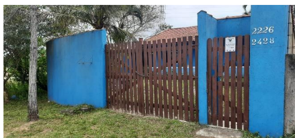
PORTÃO DE ENTRADA – VISTA EXTERNA
