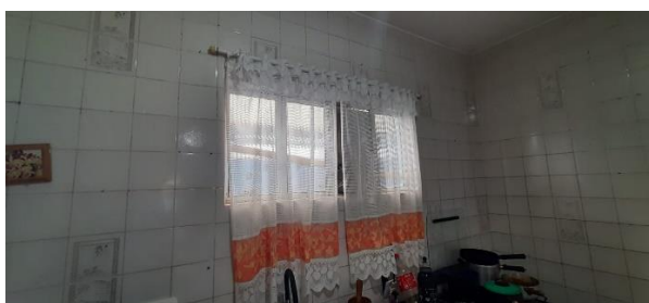
COZINHA – REVESTIMENTO DE PAREDE
