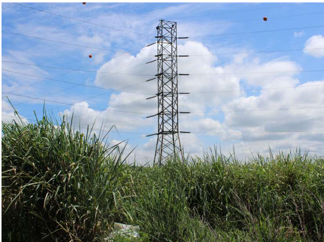
Fotografia 08 – Aspecto da faixa de servidão de linha de alta tensão que onera o imóvel em 2.550,00 m 2 de área de terreno, com 30,00 metros de largura por 85,00 metros de comprimento.
