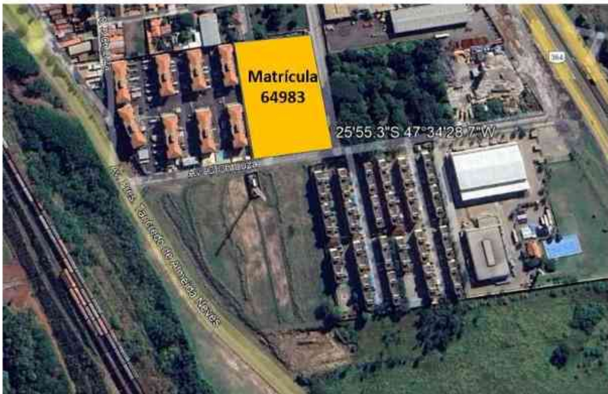
Figura 2 – Foto aérea e identificação do imóvel objeto (Fonte: Google Earth).
