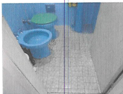
BANHEIRO – DETALHE PISO
