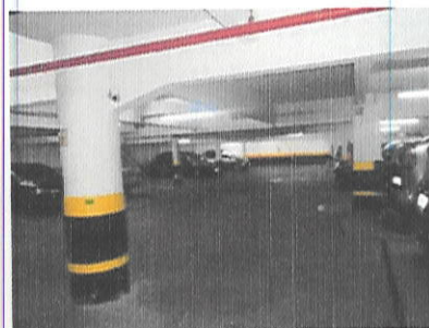
VISTA GERAL DO ESTACIONAMENTO
