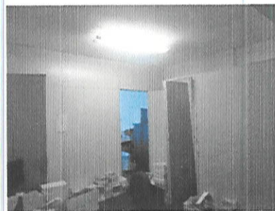
DETALHE FORRO E PAREDES
