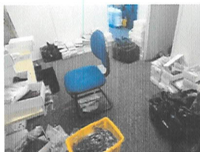
PISO COM REVESTIMENTO DE CARTETE
