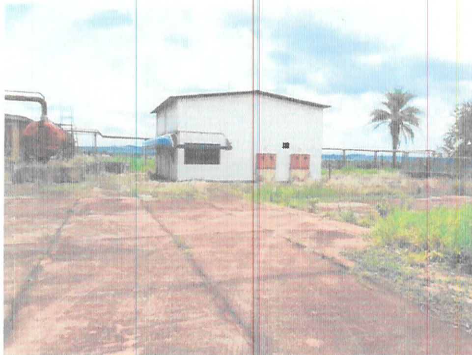
Parte pavimentada do terreno
