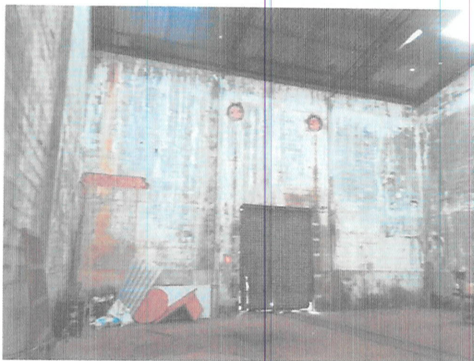
Interno do Galpão
