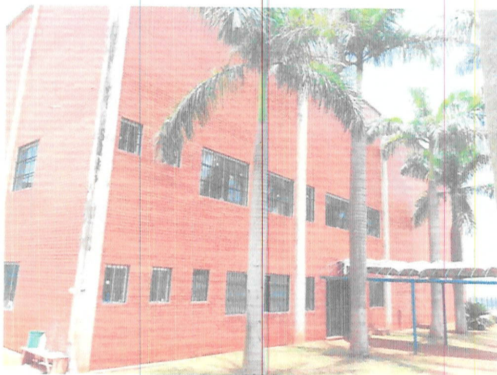
Galpão e escritórios – vista lateral
