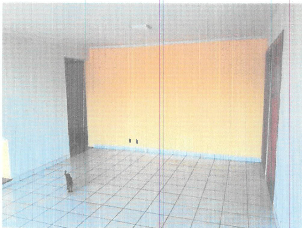
Cômodo 2 – Vista interna
