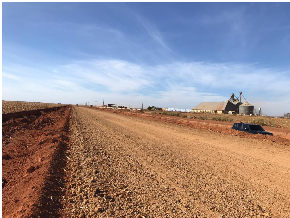
5- MT-338 – Em fase de obras de pavimentação
