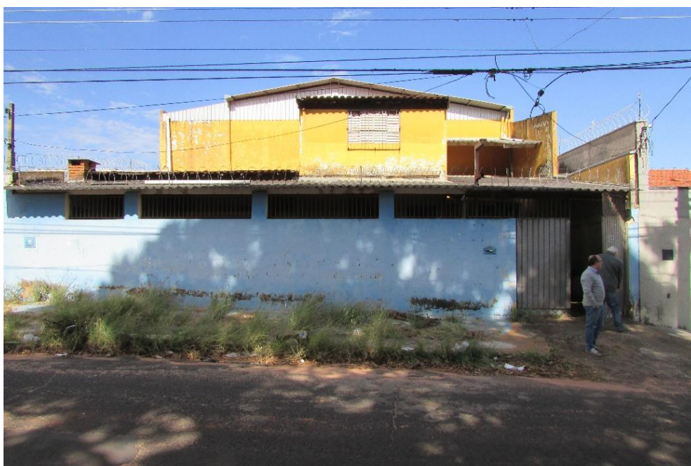
3- Vista frontal do imóvel
