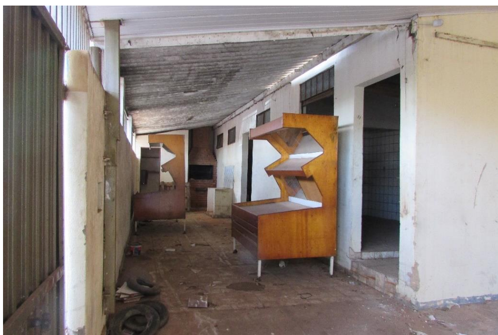
5- Corredor lateral de acesso a cozinha e vestiário
