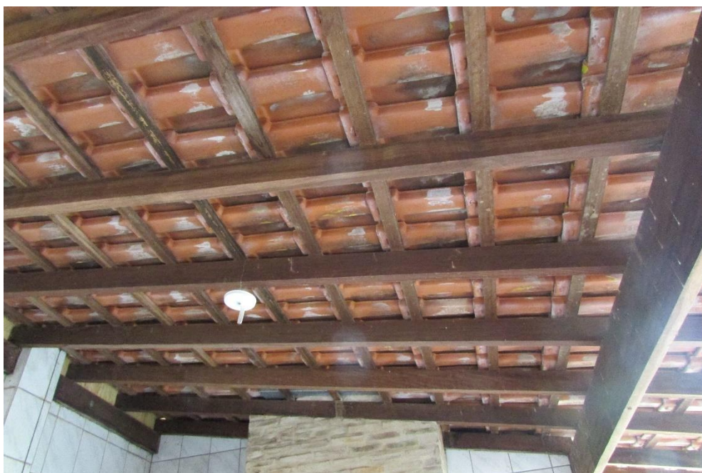
22- Cobertura da Edícula
