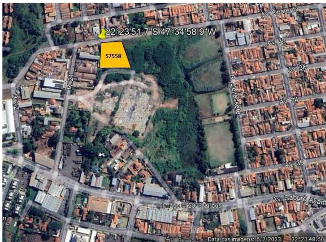
Figura 2 – Foto aérea do imóvel objeto e sua localização na cidade (Fonte: Google Earth).
