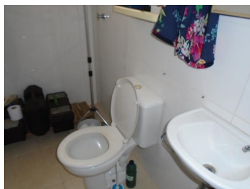
Banheiro de empregada
