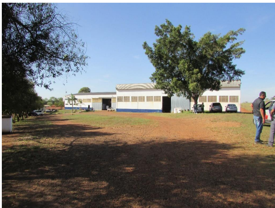
7- Acesso aos galpões – Destaque para Galpão 1
