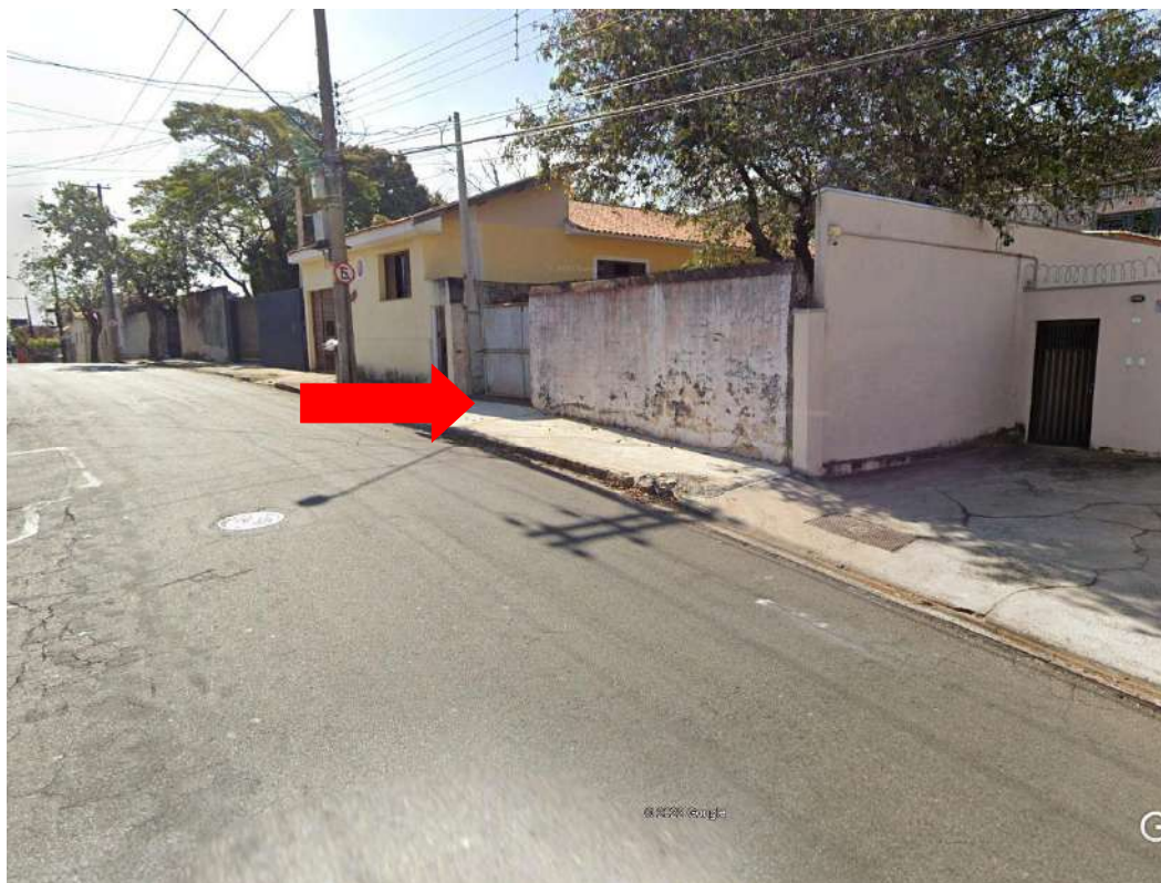
Fotografia 03 – Vista do imóvel avaliado (seta vermelha) junto ao alinhamento da Avenida São Sebastião.
