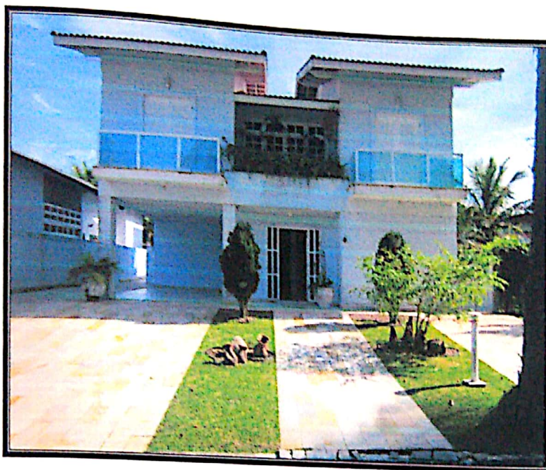
Vista da frente do imóvel avaliando.
