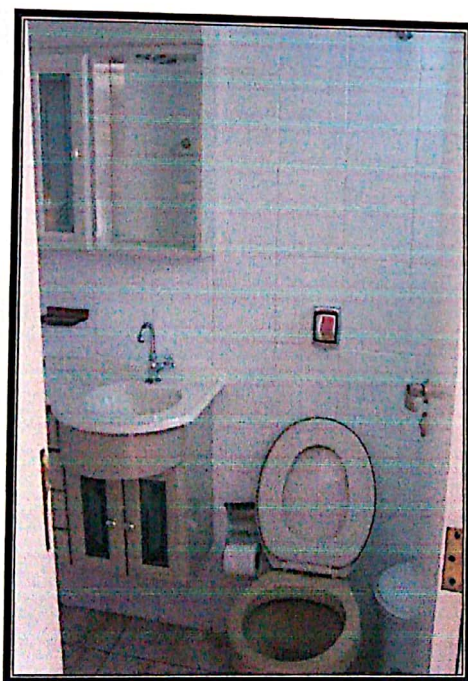
Térreo: Banheiro da suíte.
