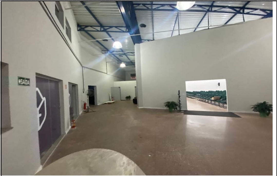
FOTO 03 – Vista geral da parte interna do imóvel com pisos de granito.
