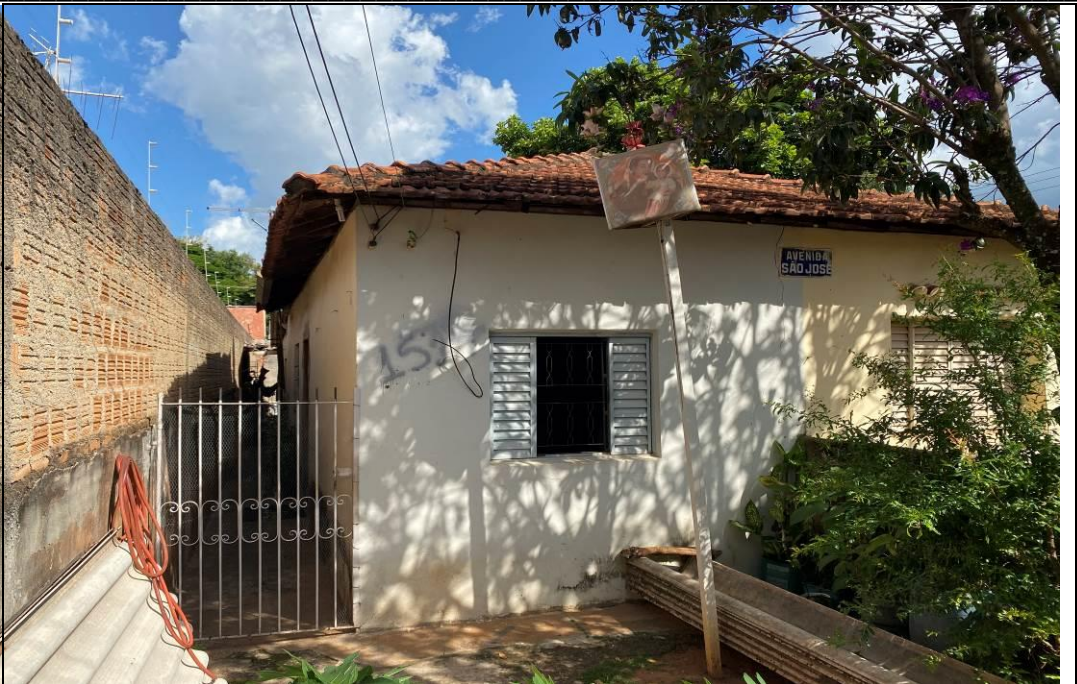
FOTO 05 – Vista geral frontal do imóvel avaliando.
