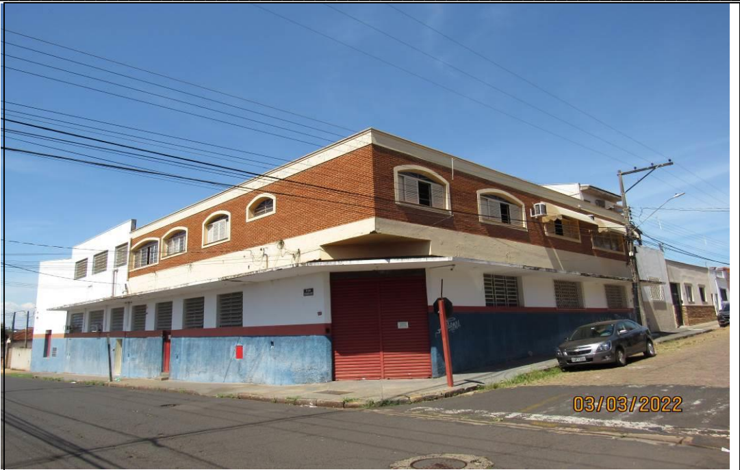
FOTO 01 – Vista frontal do imóvel avaliando.
