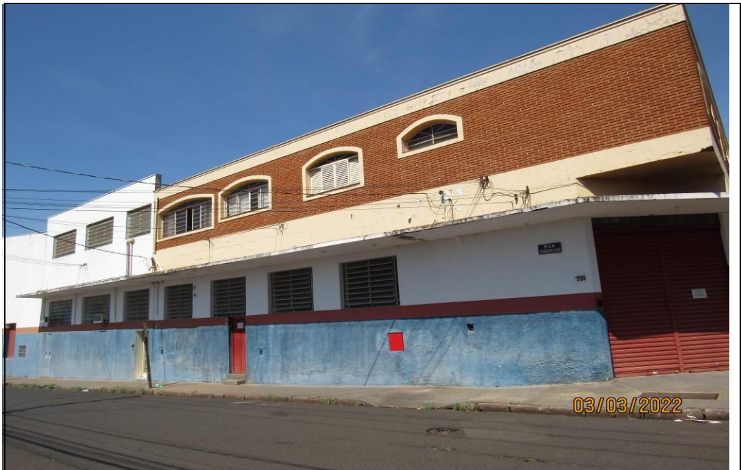
FOTO 02 – Vista frontal do imóvel avaliando.
