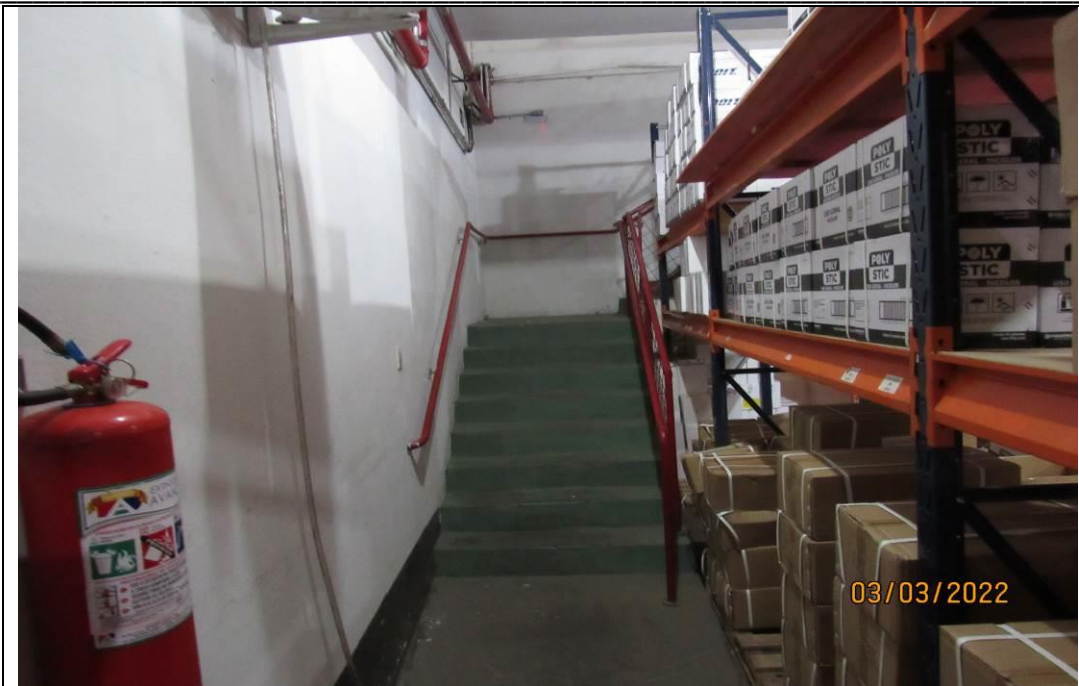
FOTO 19 – Vista geral da escada que dá acesso ao piso superior do imóvel.
