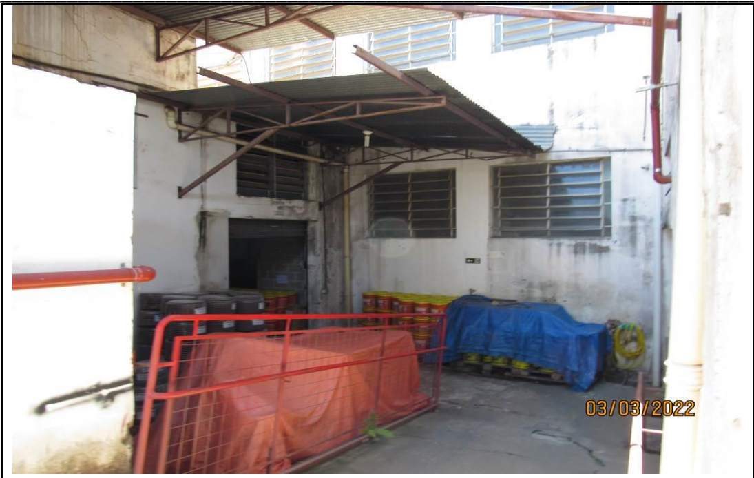
FOTO 13 – Vista da parte externa (fundos) do imóvel.
