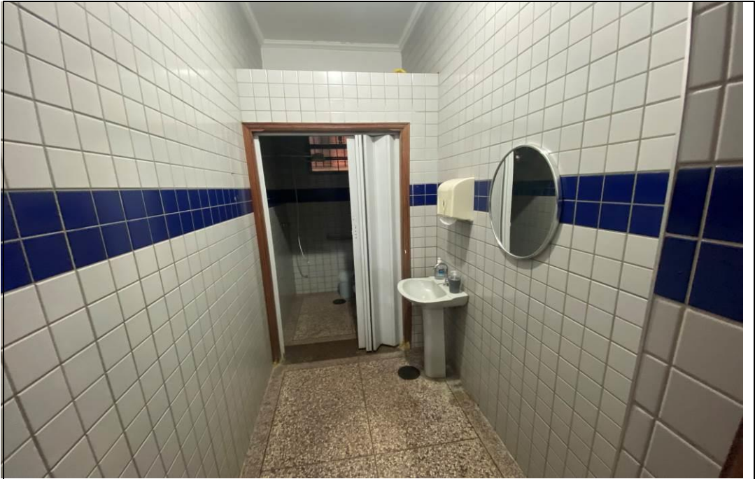
FOTO 04 – Vista geral de um dos banheiros do imóvel avaliando.
