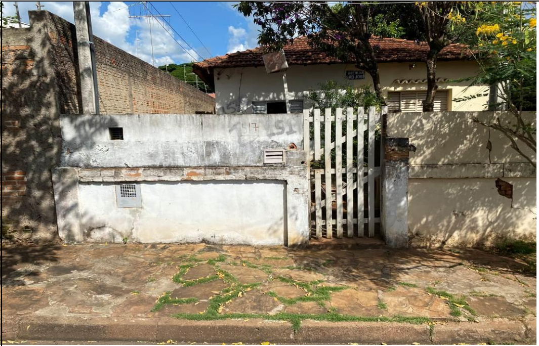
FOTO 04 – Vista geral frontal do imóvel avaliando.
