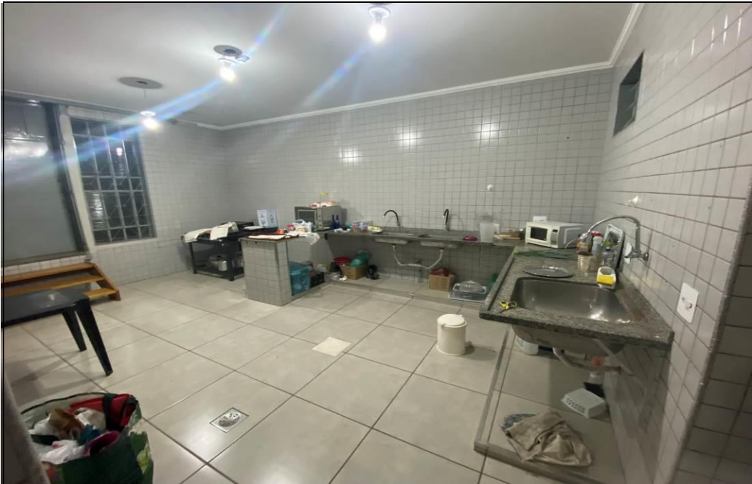
FOTO 06 – Vista geral da cozinha no imóvel.
