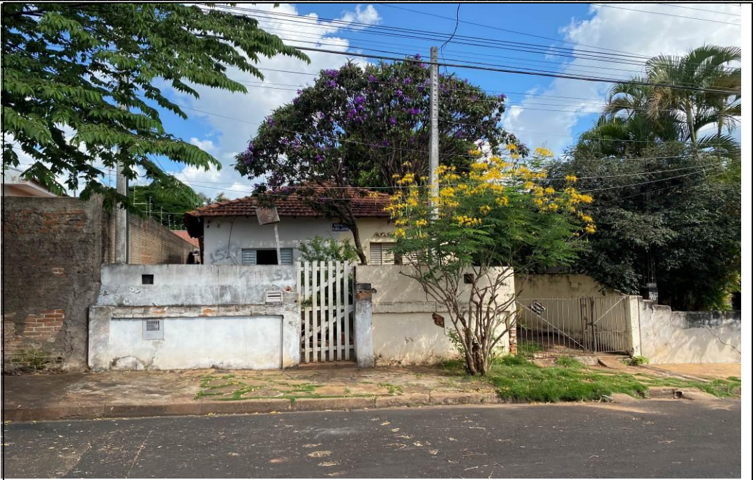
FOTO 01 – Vista geral frontal do imóvel vistoriado.
