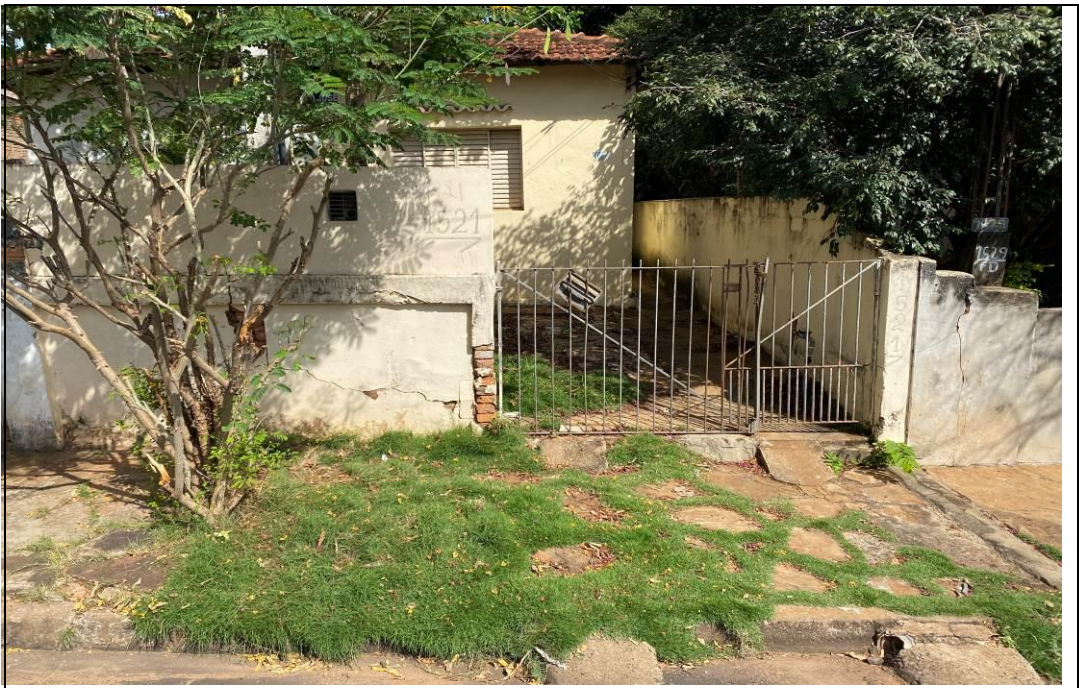
FOTO 02 – Vista geral frontal da outra parte do imóvel geminado, respectivo nº1521.
