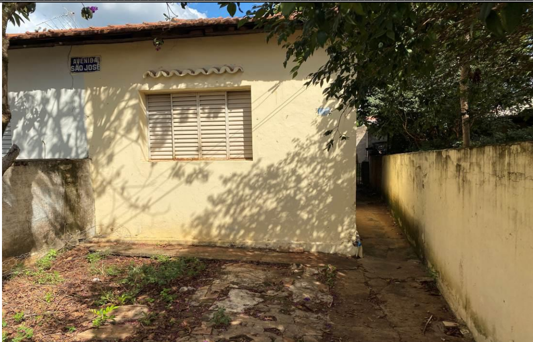
FOTO 03 – Vista geral frontal da outra parte do imóvel geminado, respectivo nº1521.
