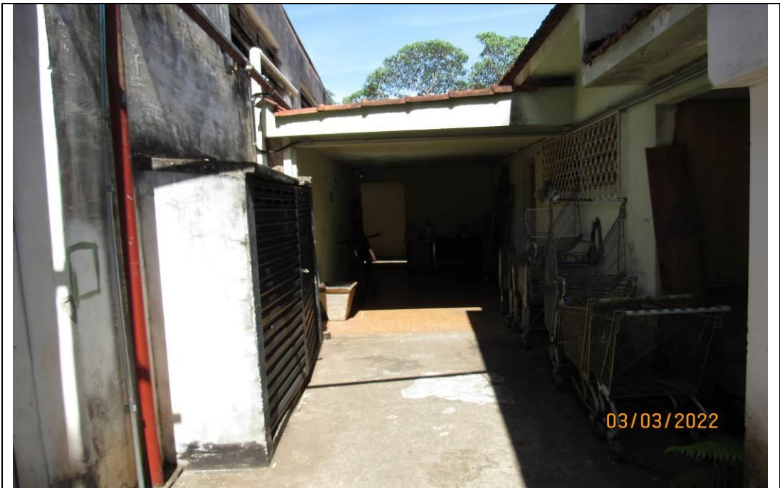
FOTO 14 – Vista geral da parte externa (fundos) do imóvel.
