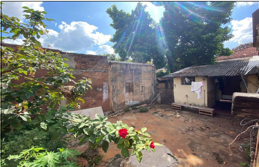
FOTO 10 – Vista geral externa do imóvel (fundos).
