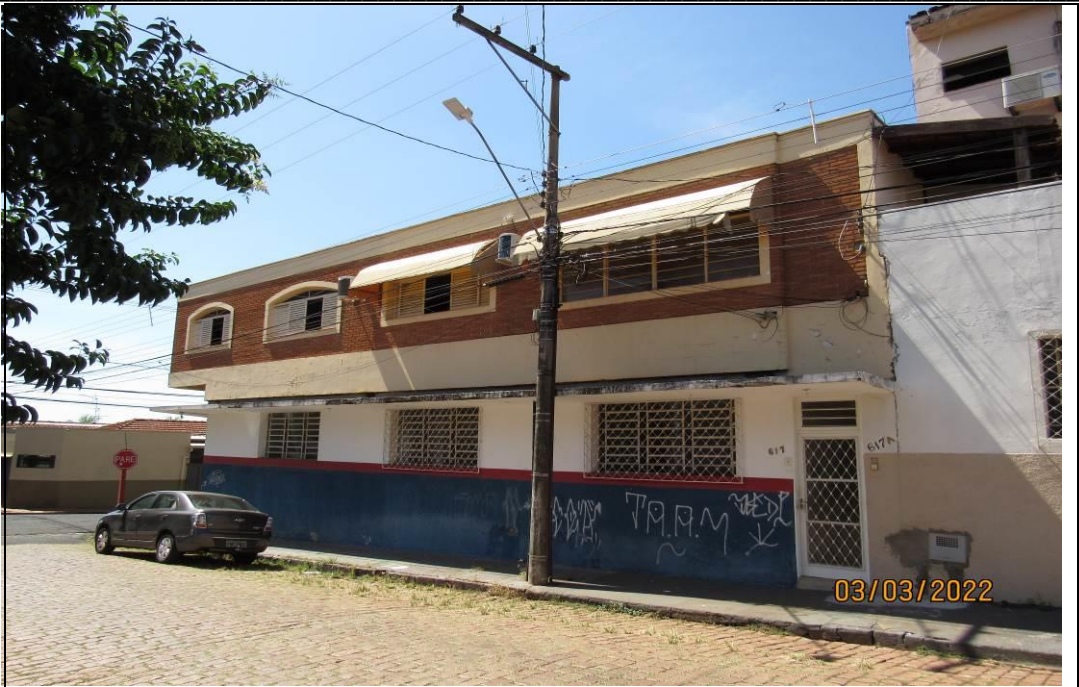
FOTO 03 – Vista lateral do imóvel pertencente a Av. Mario Ybarra de Almeida.
