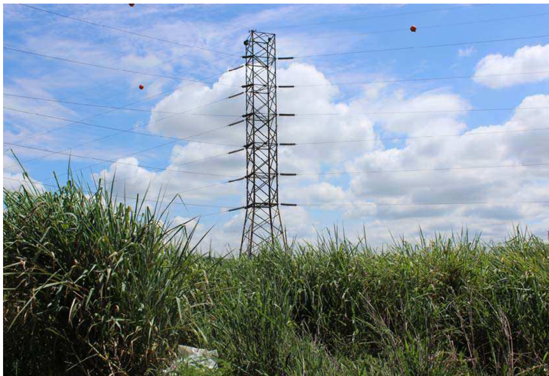
Fotografia 07 – Aspecto da faixa de servidão de linha de alta tensão que onera o imóvel em 2.550,00 m 2 de área de terreno, com 30,00 metros de largura por 85,00 metros de comprimento.
