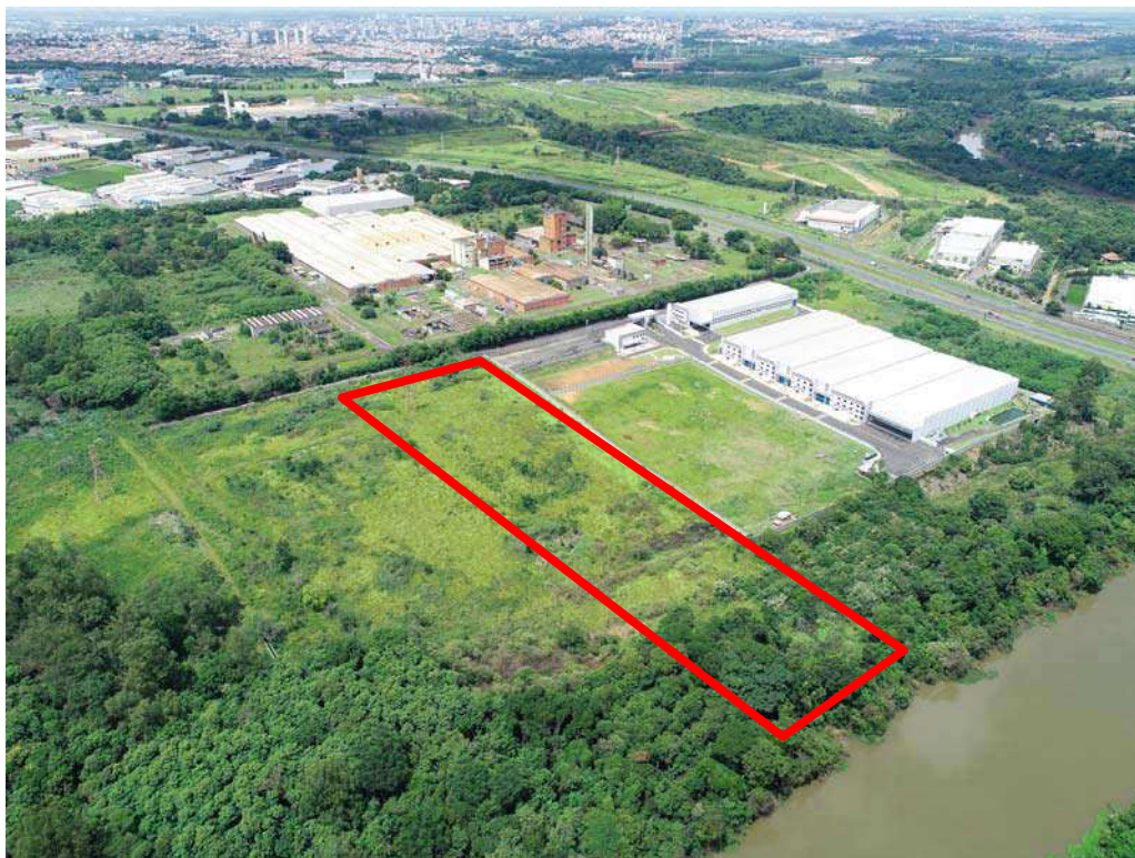
Fotografia 05 – Aspecto geral do imóvel avaliado.
