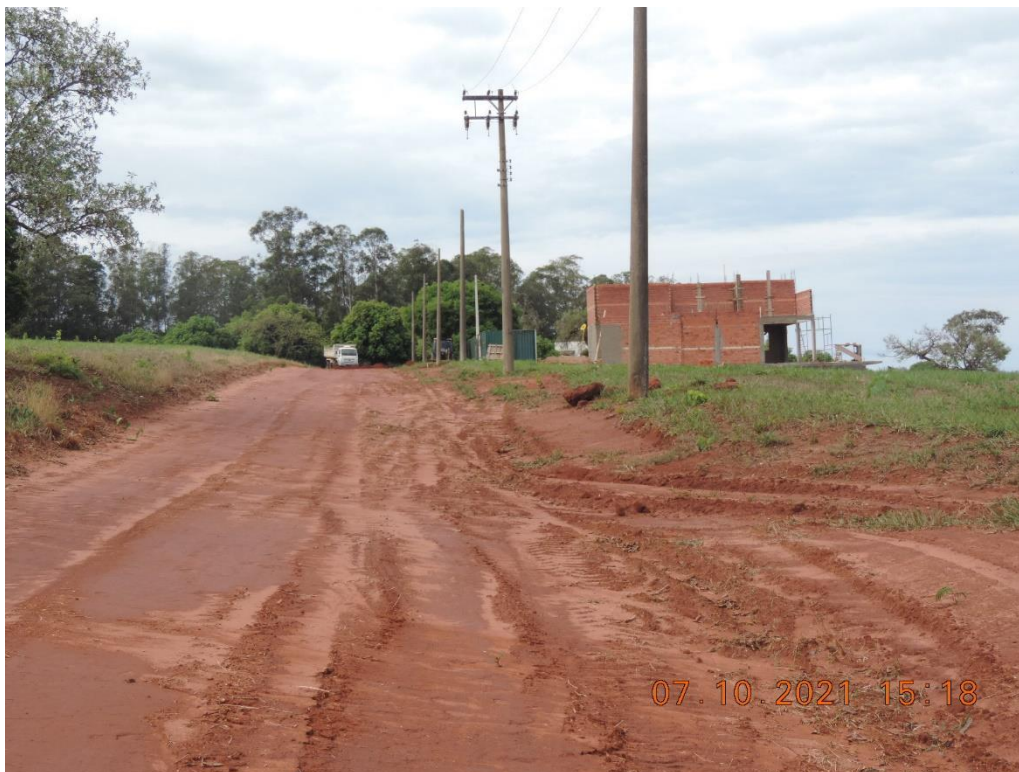
Foto 3 – Mostra rua 634 sem pavimentação.
