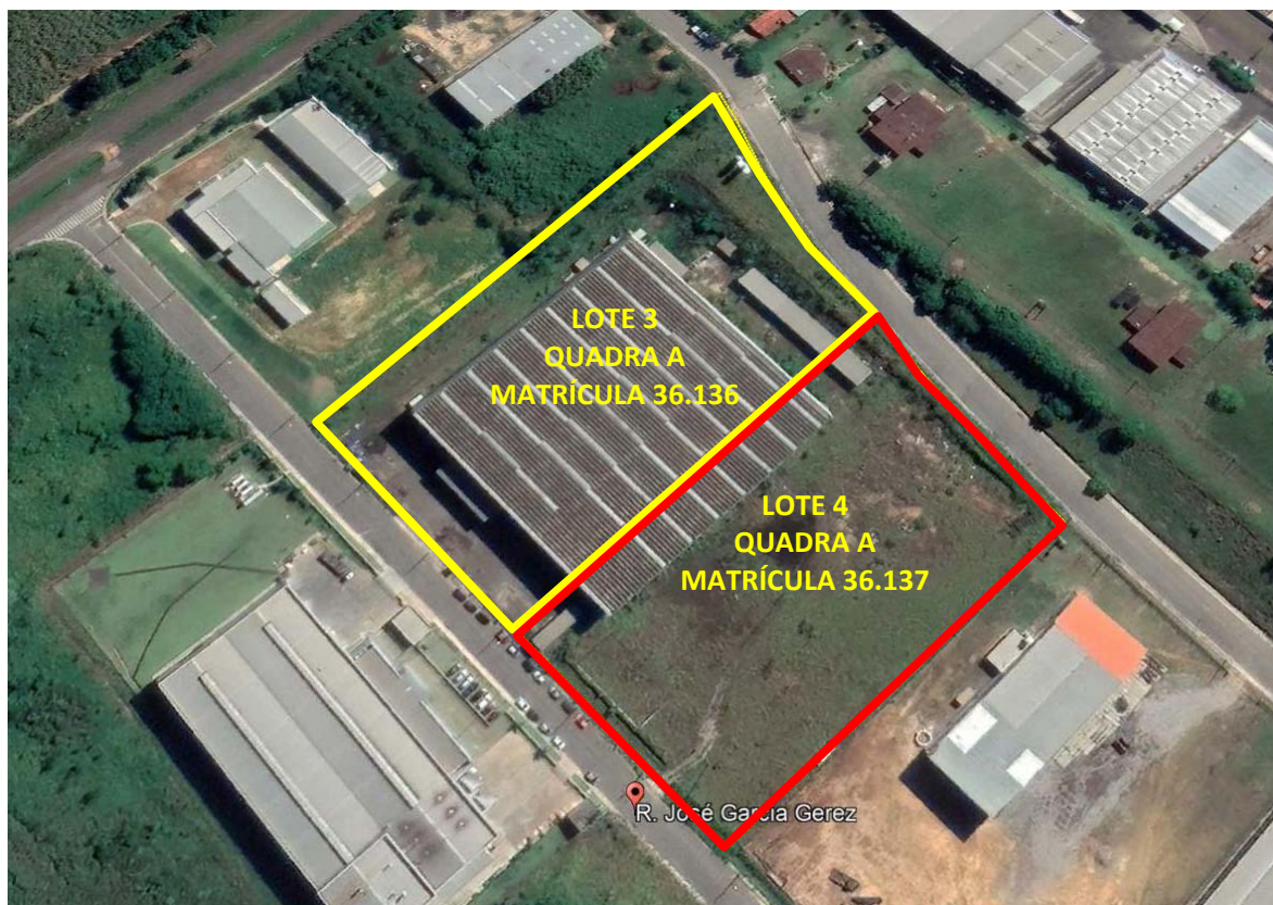
Fotografia 01 – Vista dos imóveis avaliados junto ao alinhamento da Rua José Garcia Gerez.
