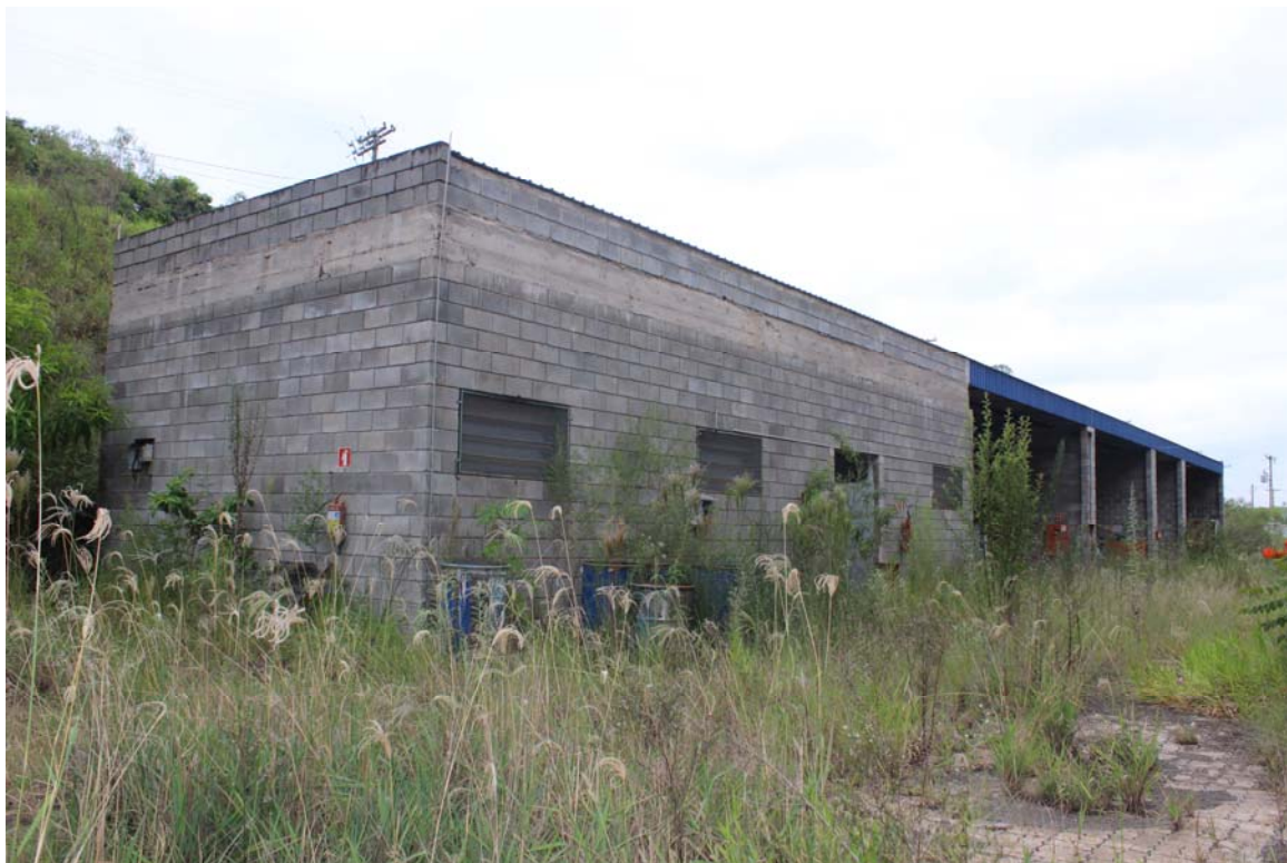
Fotografia 11 – Aspecto do Anexo Técnico.
