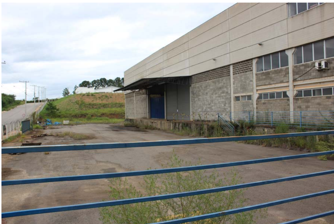
Fotografia 04 – Aspecto da frente do galpão principal.
