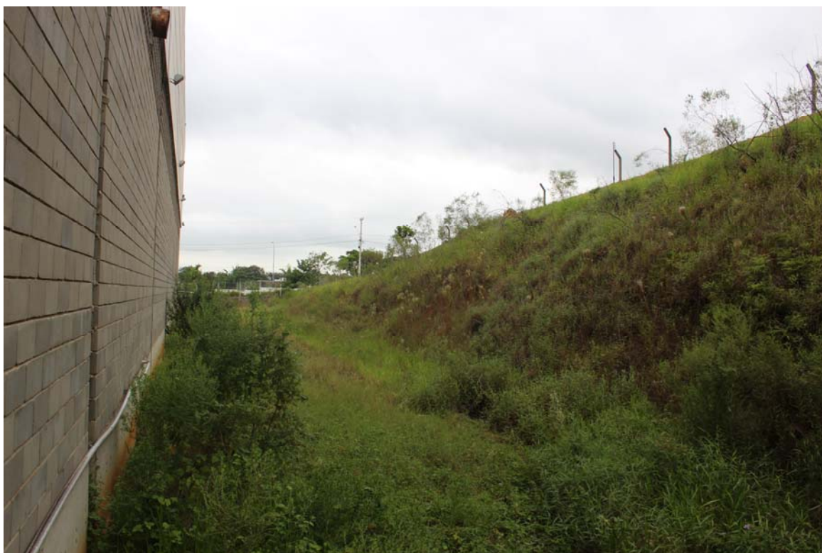
Fotografia 12 – Aspecto dos fundos do imóvel junto ao alinhamento da Rua Sebastião de Campos.
