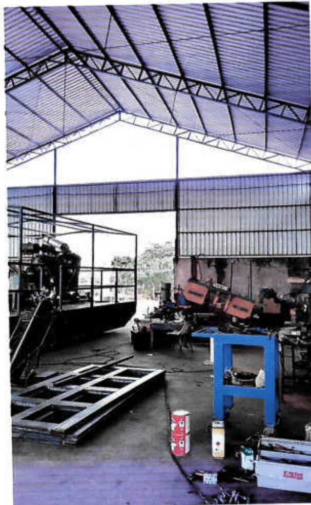
Vista parcial da propriedade, observando a face interna do barracão.
