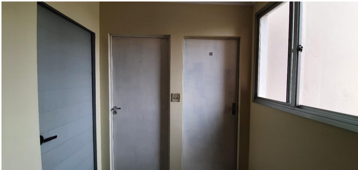
Figura 6: Hall de acesso à unidade avaliando nº 21 do bloco 02
