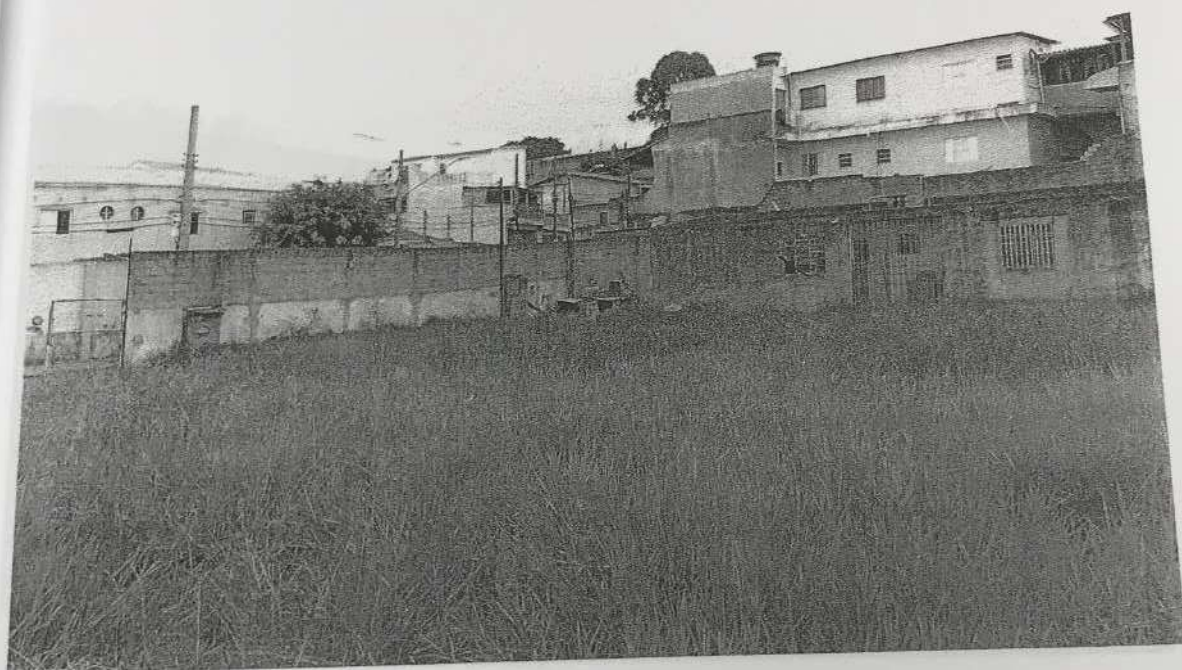
FOTO 13: VISTA PARCIAL DA EDIFICAÇÃO SEM VALOR COMERCIAL.
