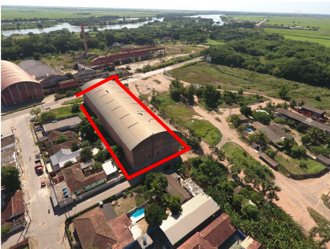
Fotografia 05 – Aspecto do imóvel avaliado (em vermelho).
