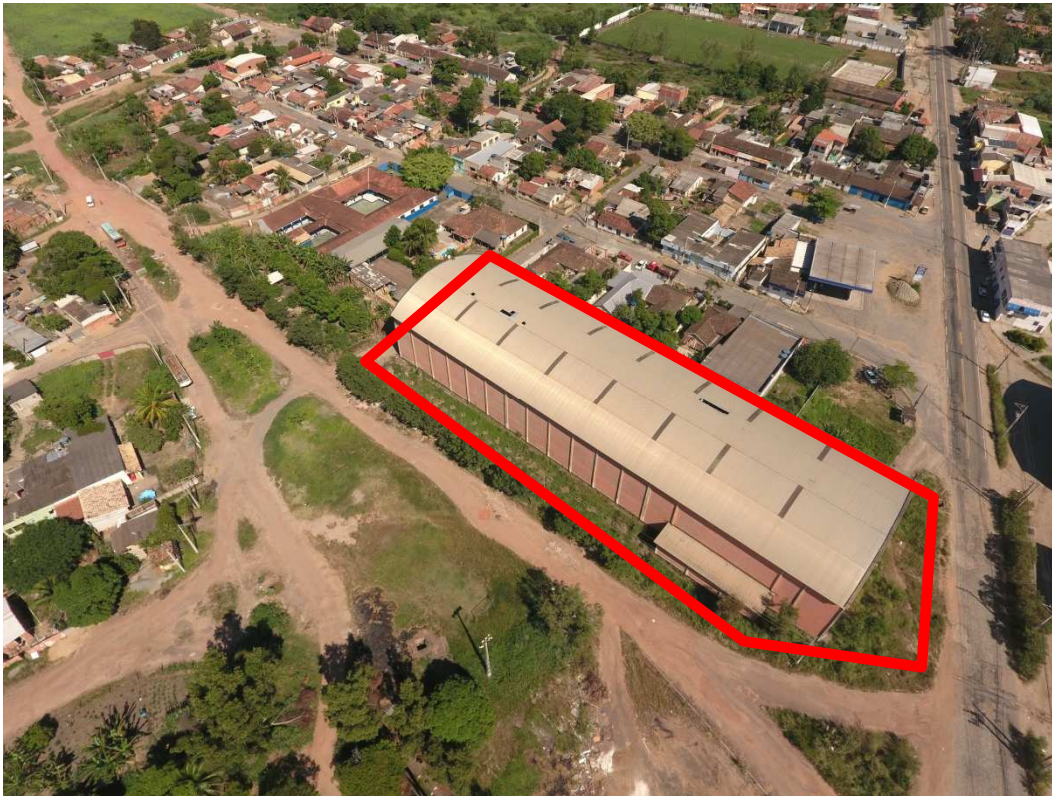
Fotografia 04 – Aspecto do imóvel avaliado (em vermelho).
