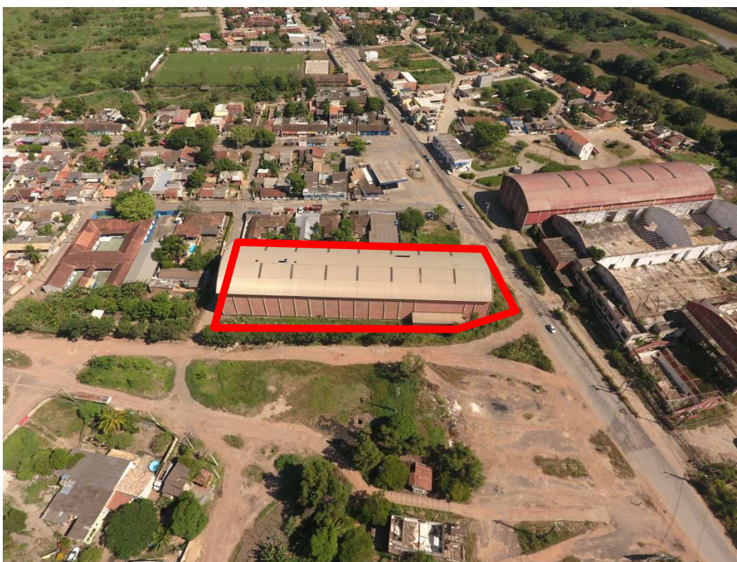
Fotografia 03 – Aspecto do imóveis avaliado (em vermelho), situado no alinhamento da Rodovia RJ 158.
