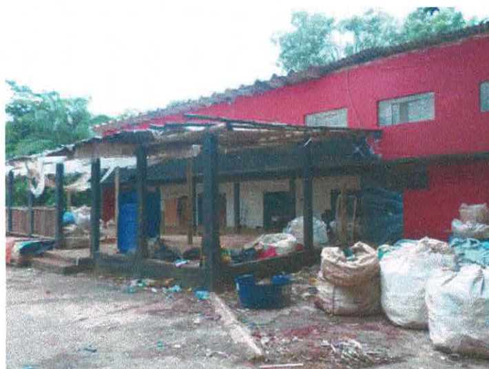
Fotografia 09 – Aspecto das construções existentes (Edificação 03).
