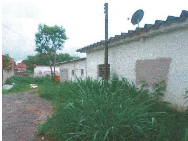
Fotografia 11 – Aspecto geral do imóvel avaliado.
