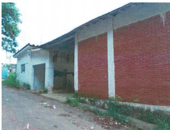
Fotografia 06 – Aspecto das construções existentes (Galpão 01).
