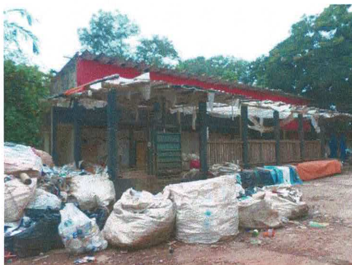
Fotografia 13 – Aspecto geral do imóvel avaliado.
