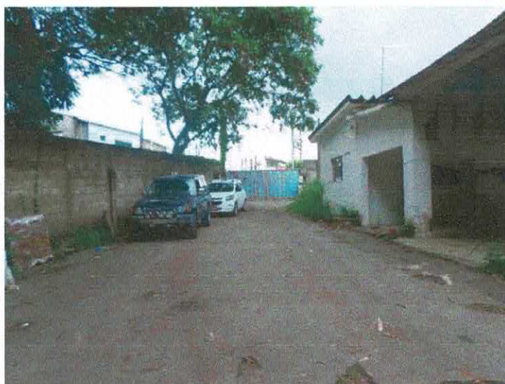
Fotografia 12 – Aspecto geral do imóvel avaliado.
