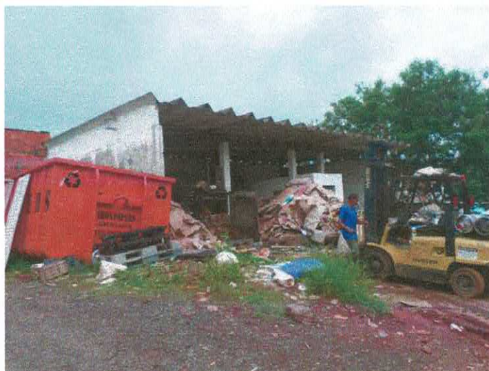
Fotografia 08 – Aspecto das construções existentes (Galpão 02).
