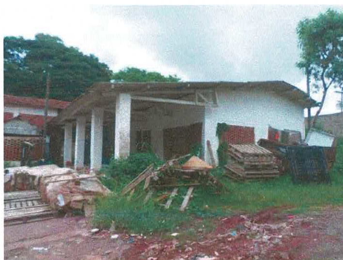
Fotografia 07 – Aspecto das construções existentes (Galpão 01).
