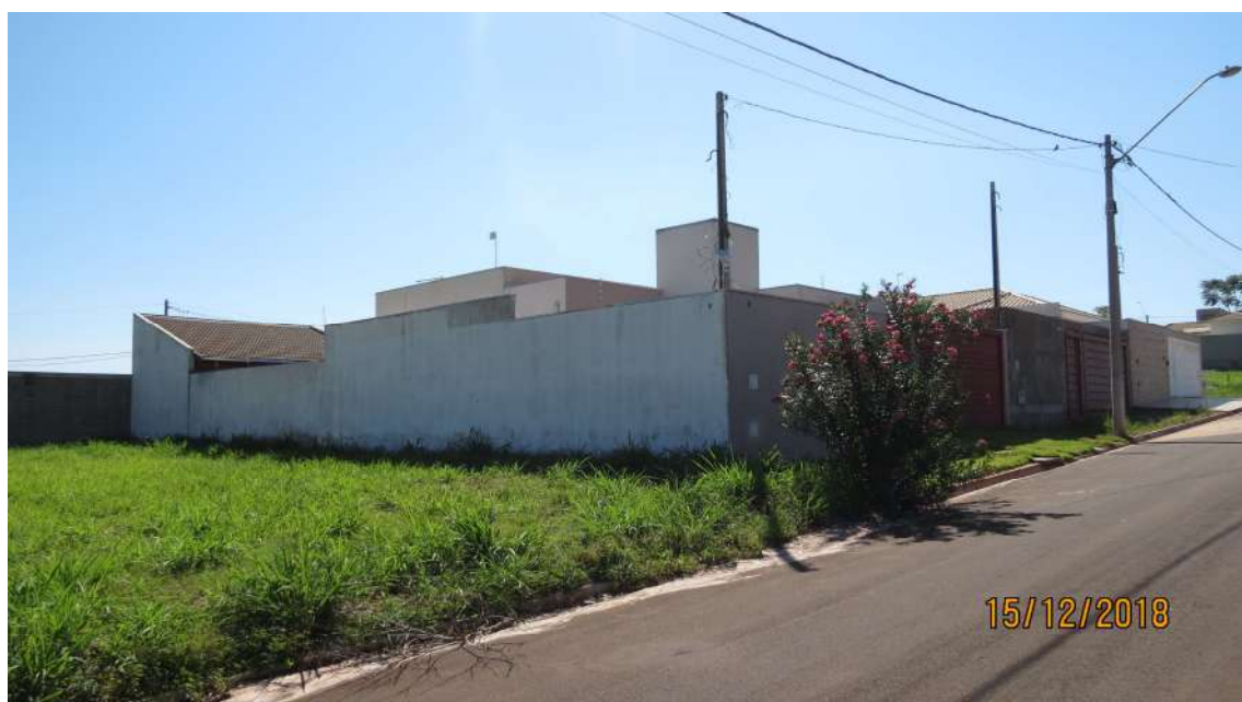
Figura 5 – Lateral esquerda da edificação.
