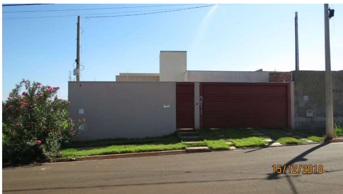
Figura 4 – Parte da frente da edificação, com muro de fechamento.
