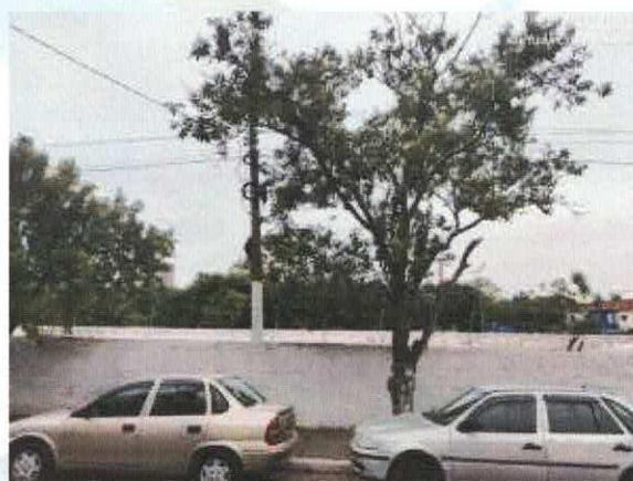
Figura 3 - Lado oposto (Av do Estado) Muro alto para contenção de água
