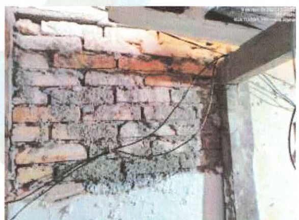
Figura 10 - Cobertura com telha de amianto na lateral
