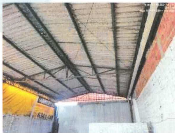
Figura 4 - Cobertura em estrutura metálica ao fundo
