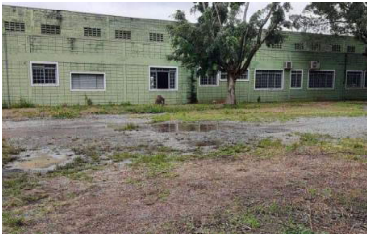
Fotografia 12 – Aspecto geral da área avaliada, suas construções e benfeitorias.
