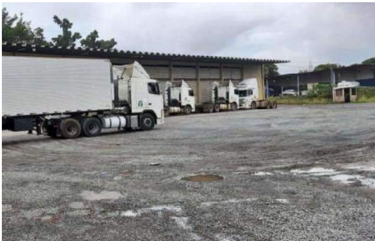
Fotografia 08 – Aspecto geral da área avaliada.
