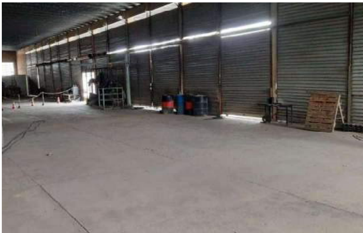
Fotografia 11 – Aspecto geral da área avaliada, suas construções e benfeitorias.
