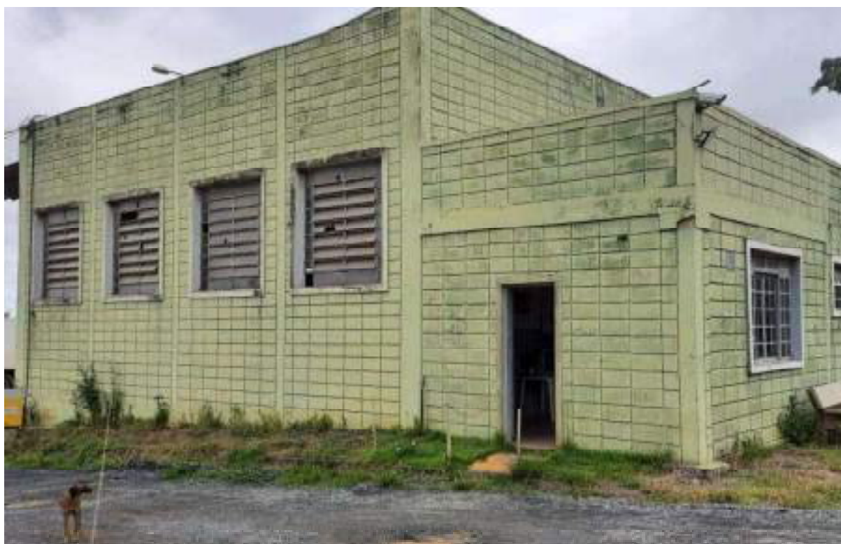
Fotografia 05 – Aspecto geral da área avaliada, suas construções e benfeitorias.
