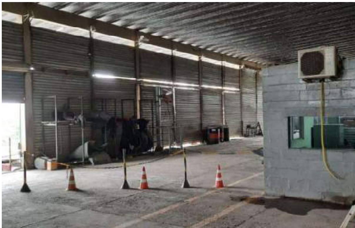
Fotografia 10 – Aspecto geral da área avaliada, suas construções e benfeitorias.
