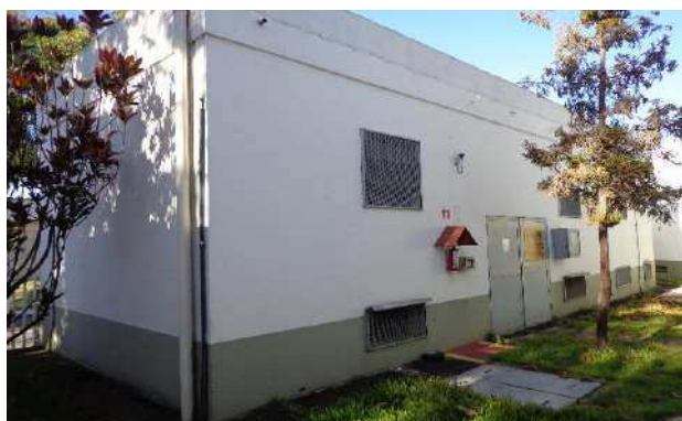
FOTO 109 cabine de força
