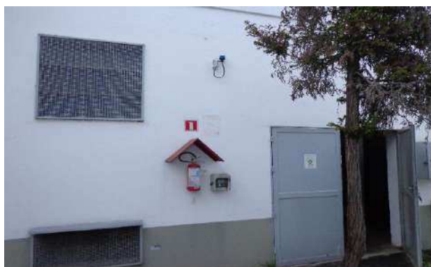
FOTO 108 cabine de força
