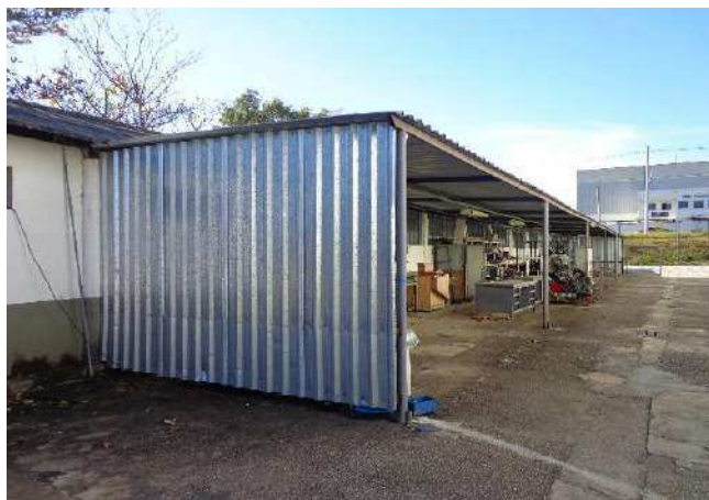
FOTO 155 Vista da cobertura.
