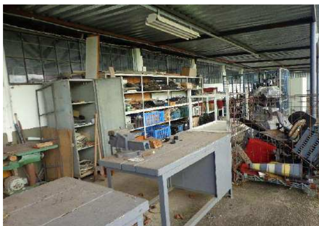
FOTO 156 Outra vista da cobertura
