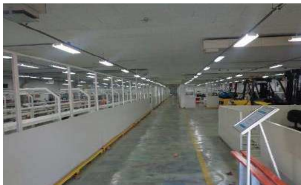
FOTO 57 área de circulação
