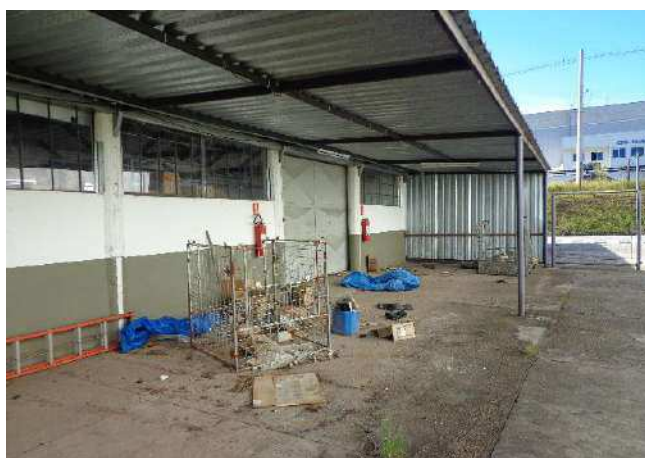
FOTO 157 Vista da cobertura por outro ângulo.
