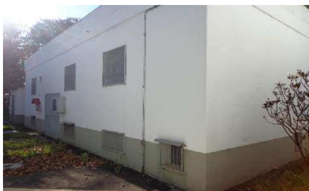
FOTO 110 cabine de força
