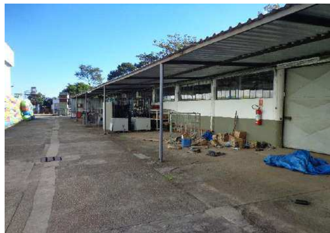
FOTO 158 Vista da cobertura.
