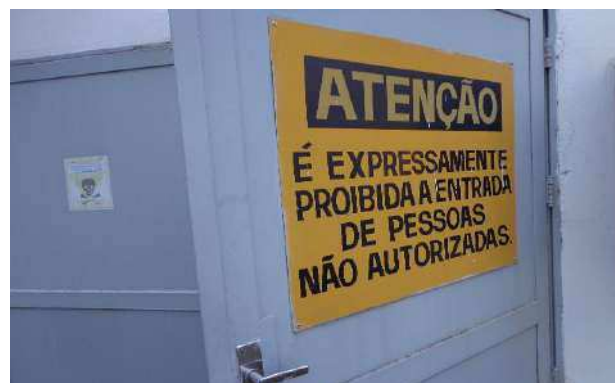
FOTO 111 cabine de força.
