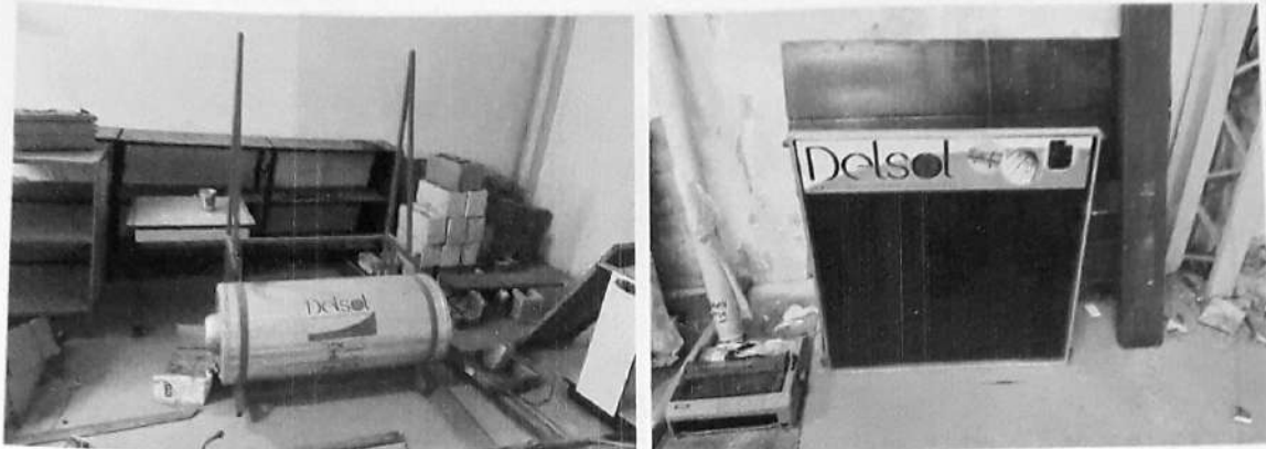
32 e 33 – BOILER E PLACA DE AQUECIMENTO
