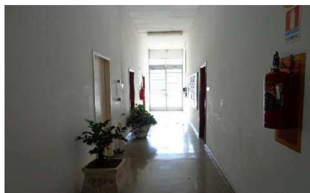
FOTO 28 área de circulação
