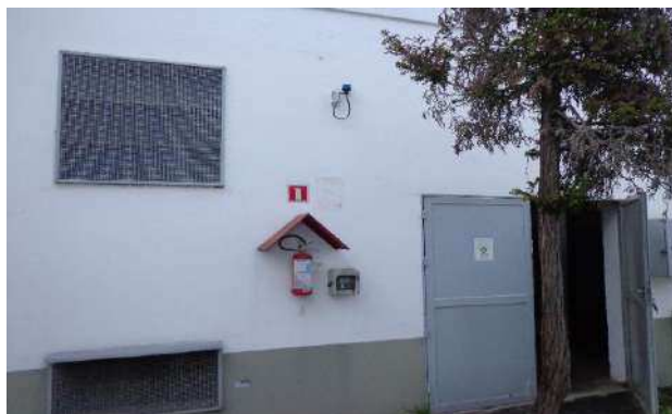
FOTO 108 cabine de força
