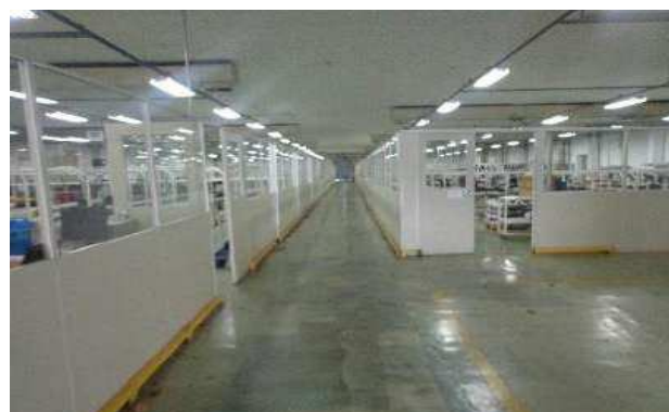
FOTO 61 área de circulação
