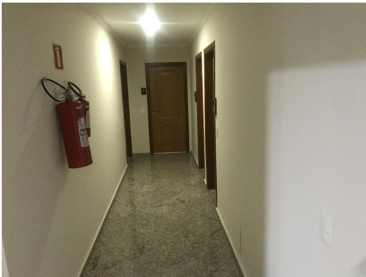
VISTA DO CORREDOR DE CIRCULAÇÃO DO 14º ANDAR.
