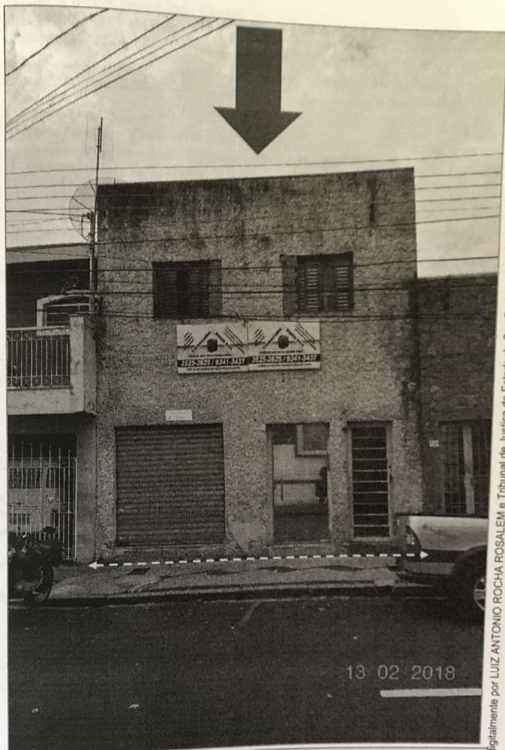
Foto nº01: Vista parcial da fachada do imóvel a ser avaliando, descrito no TERMO DE PENHORA E DEPÓSITO de Fls. 3 desta Carta Precatória, localizado na Avenida 8 nº100 , entre as Ruas 1 e 2, região central da cidade de Rio Claro SP. Abaixo, temos uma visão geral da Avenida 8. Fotografia do dia 13/02/18 onde encontramos o imóvel fechado.
