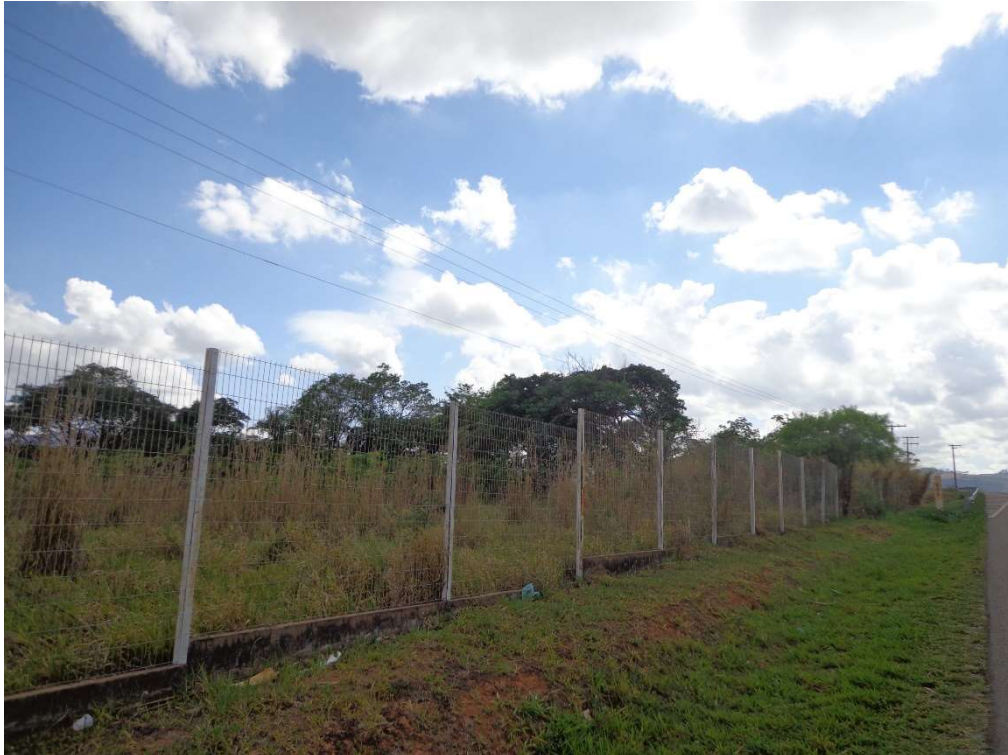
4- Cerca de delimitação de área às margens da Rodovia SP-342
