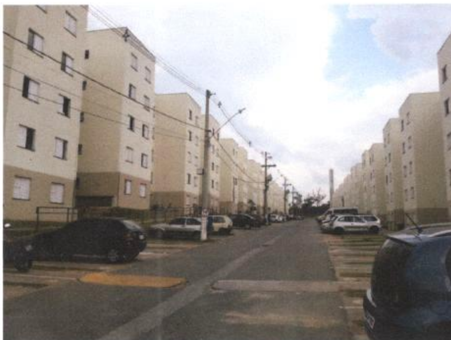
20- Via de acesso às torres
