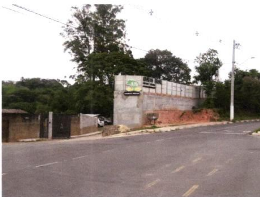
23- Via de acesso ao condomínio
