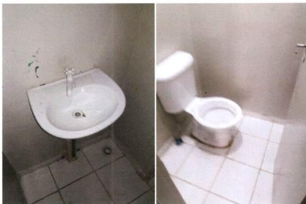
15- Banheiro Salão de eventos
