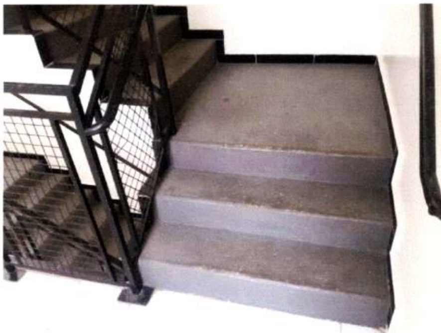
8- Acesso aos pavimentos
