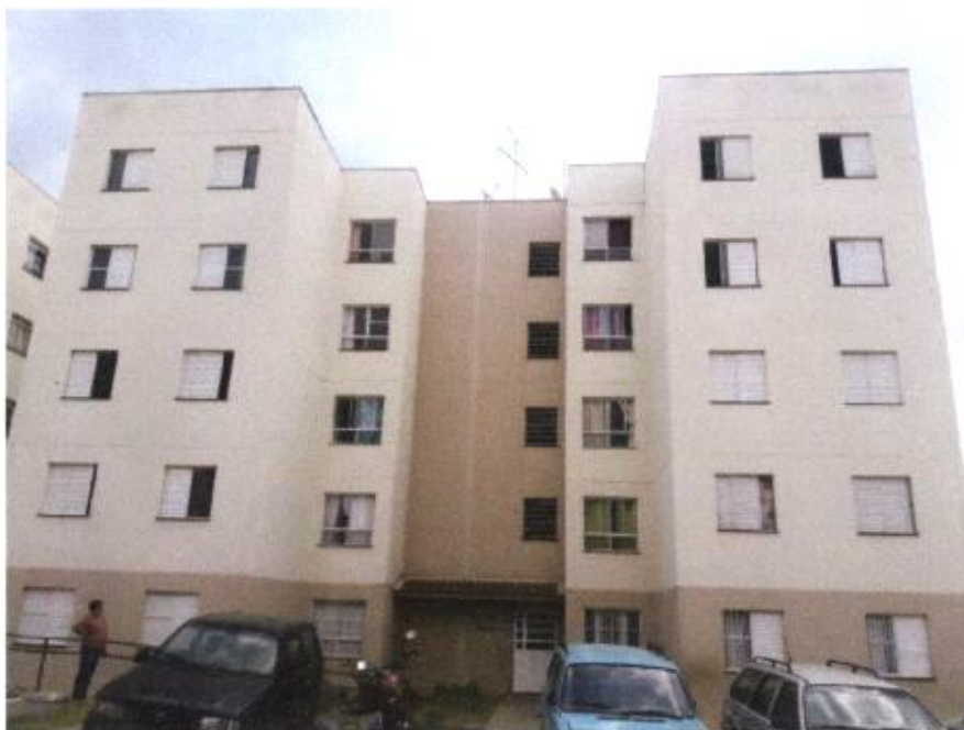
3- Torre 3 – alvo da vistoria
