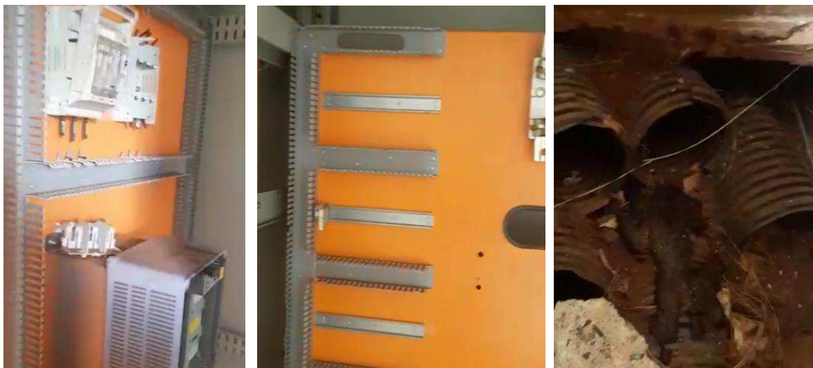
14, 15 e 16- Pannel danificado e cabos removidos
