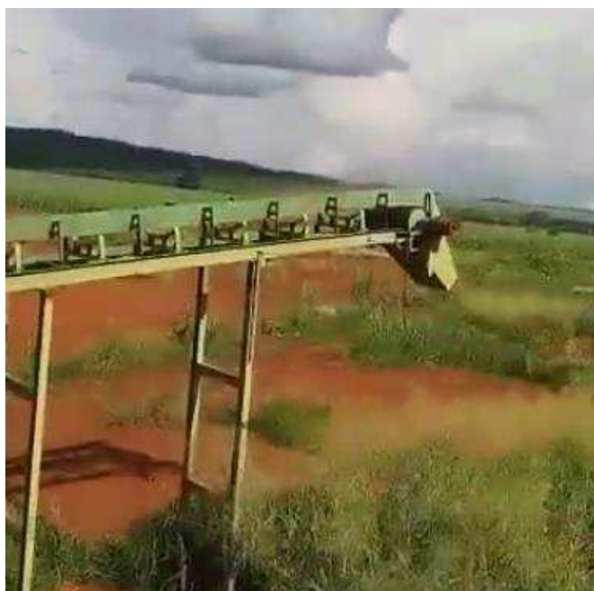
13- Detalhe esteira de bagaço sem motor.
