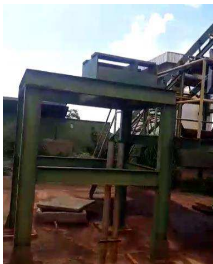
2- Base estrutura metálica
