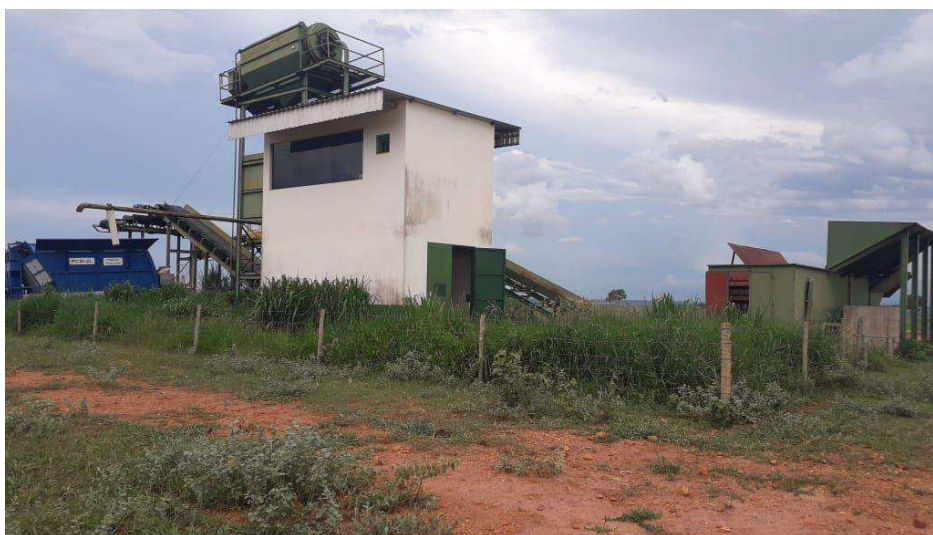
1- Equipamentos Usina São Simão
