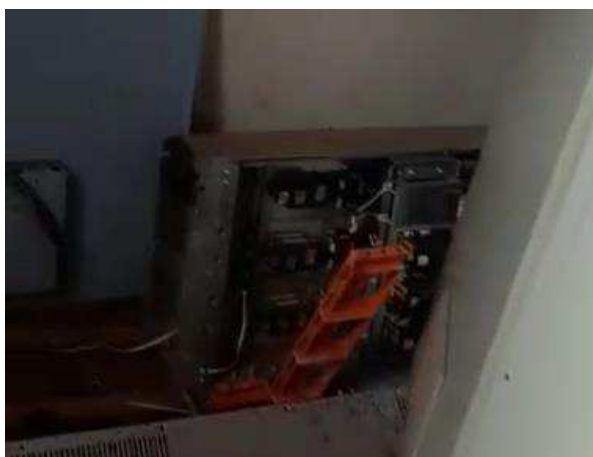
17- Componentes elétricos do painel danificados
