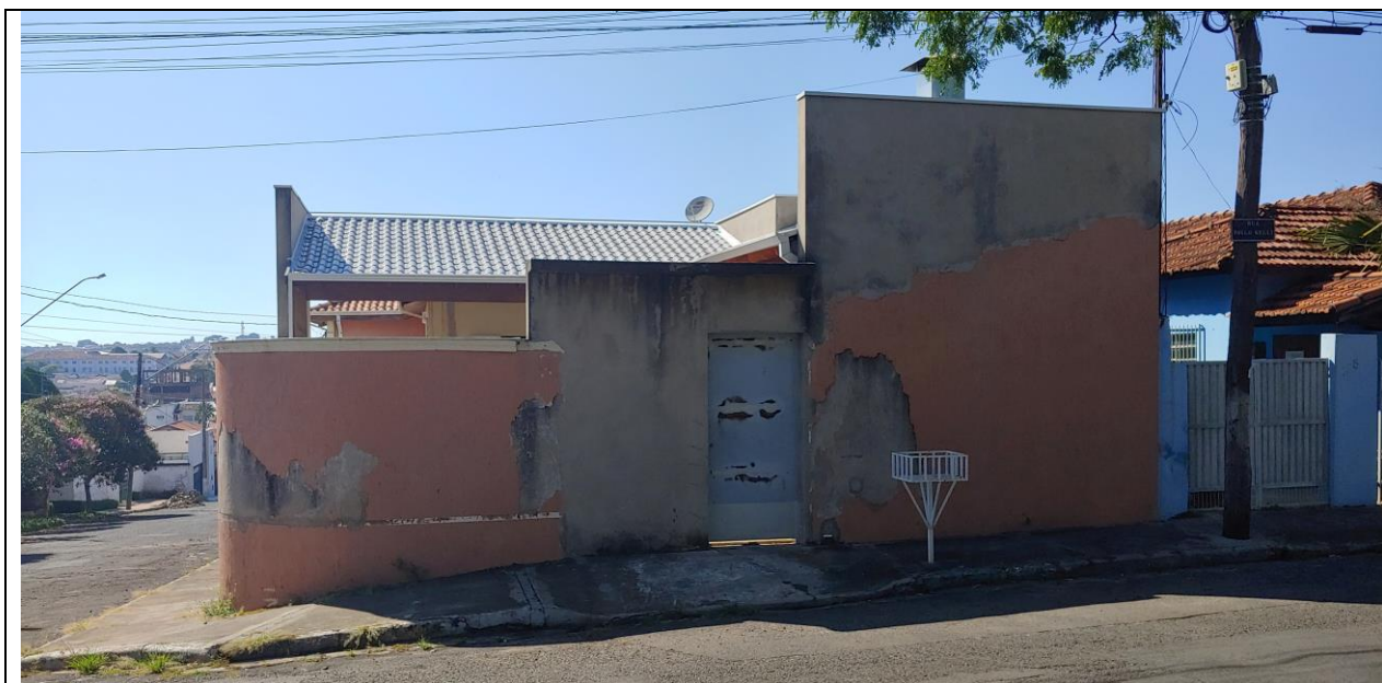
Foto 2: Fachada lateral do imóvel. Vista de quem da Rua Paulo Nelli olha.
