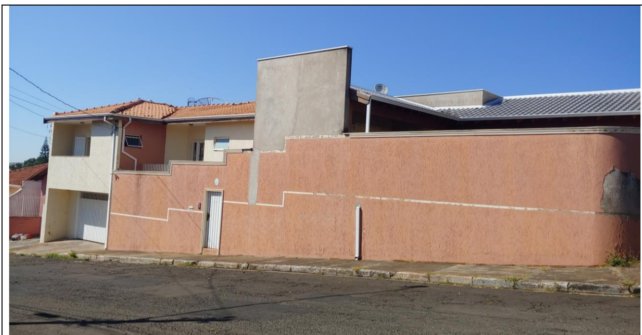
Foto 1: Fachada frontal do imóvel. Vista de quem da Avenida Sebastiana Leite olha.
